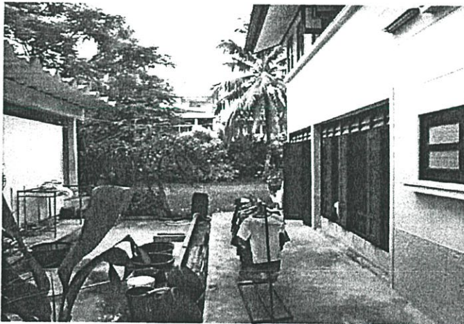
รูปที่ 5.60 บริเวณทางเชื่อมระหว่างห้องน้ำกับอาคารนอน ที่ใช้เป็นลานซักล้าง
