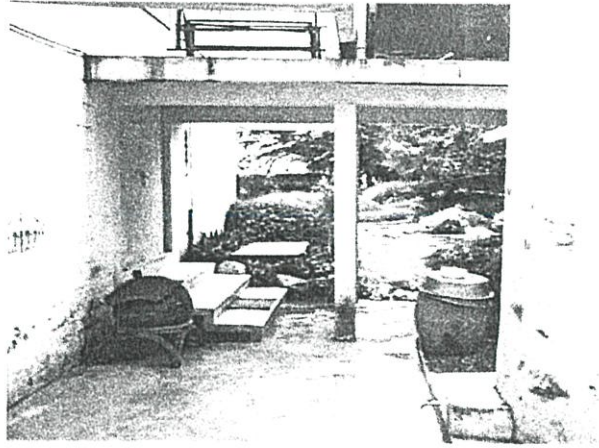
รูปที่ 5.25 แสดงถึงการเชื่อมต่อ และการเข้าถึงห้องน้ำ ของอาคารนอนในสถานสงเคราะห์ เยาวชนมูลนิธิมหาราช
