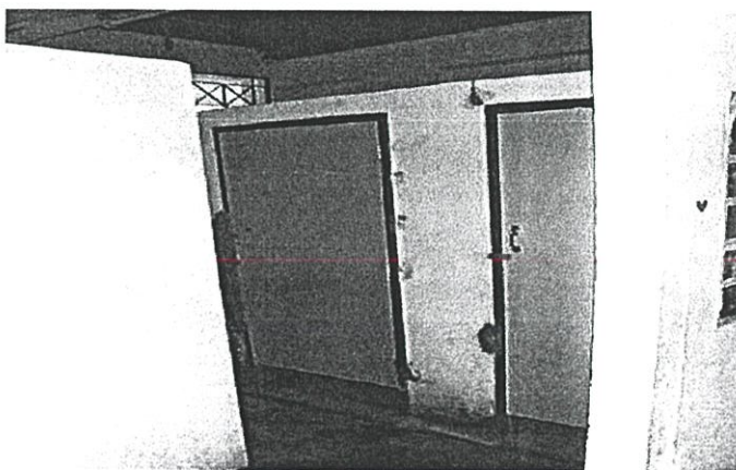
รูปที่ 4.11 บริเวณพื้นที่ห้องน้ำ
