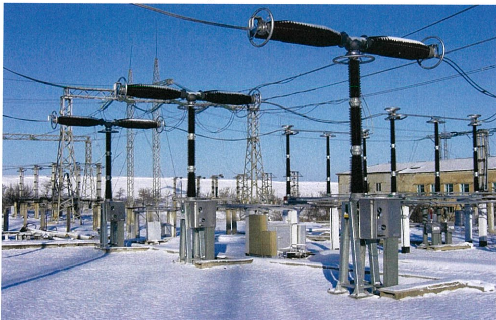
รูปที่2.8 แสดงลักษณะของ Live Tank Circuit Breaker
