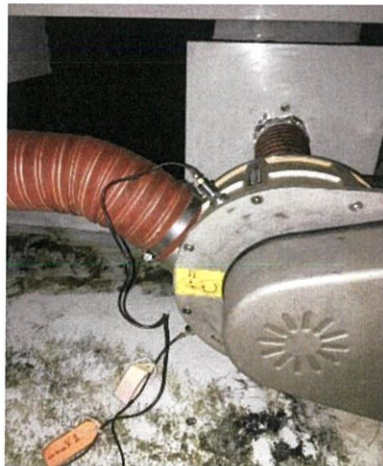
รูปที่ 3.22 ตำแหน่งการติดตั้ง Vibration Transmitter ในลักษณะตั้งฉากกัน
