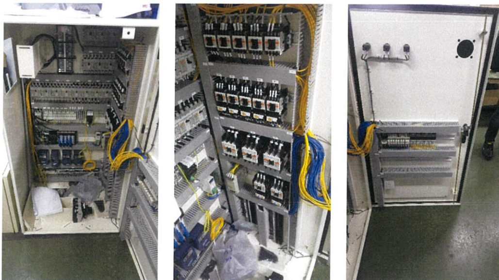
รูปที่ 3.15 กระบวนการ Wiring ตู้ควบคุมไฟฟ้า (Control Box)
