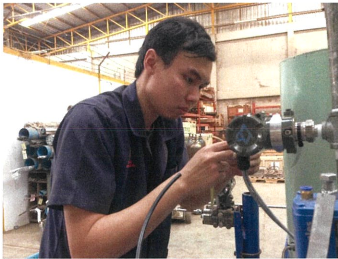
รูปที่ 3.53 การเข้าสาย Pressure Transmitter
