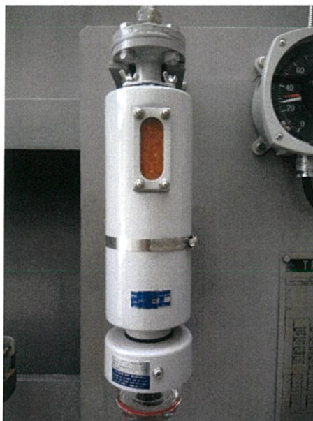
ภาพที่ 2.10 กระจเปาะกรองความชื้น
