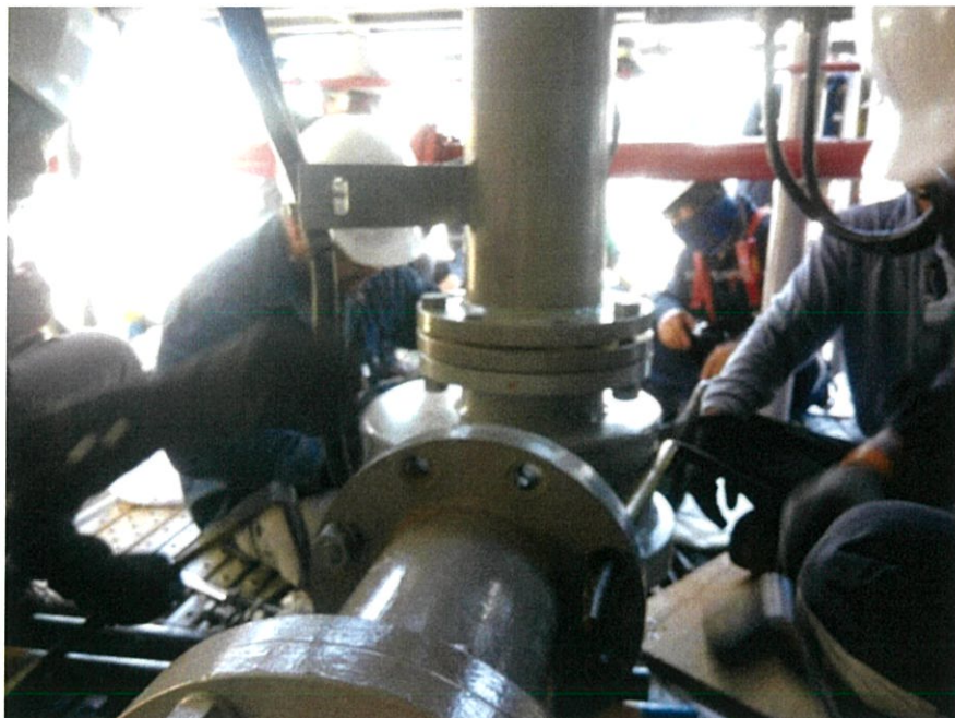
ภาพที่ 4.7 การติดตั้ง Oil cooling pump
