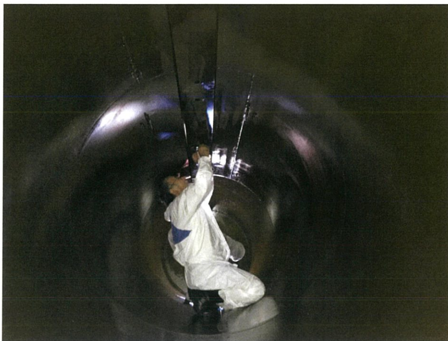
ภาพที่ 4.5 การตรวจสอบถึงน้ำมันสำรอง
