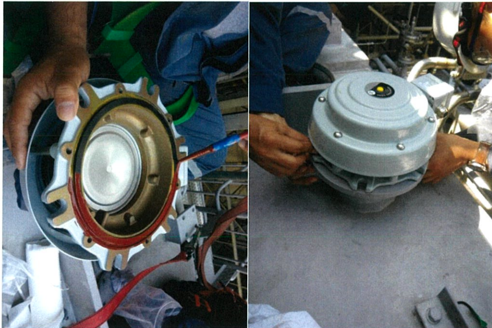
ภาพที่ 4.9 การเปลี่ยน Pressure relief
