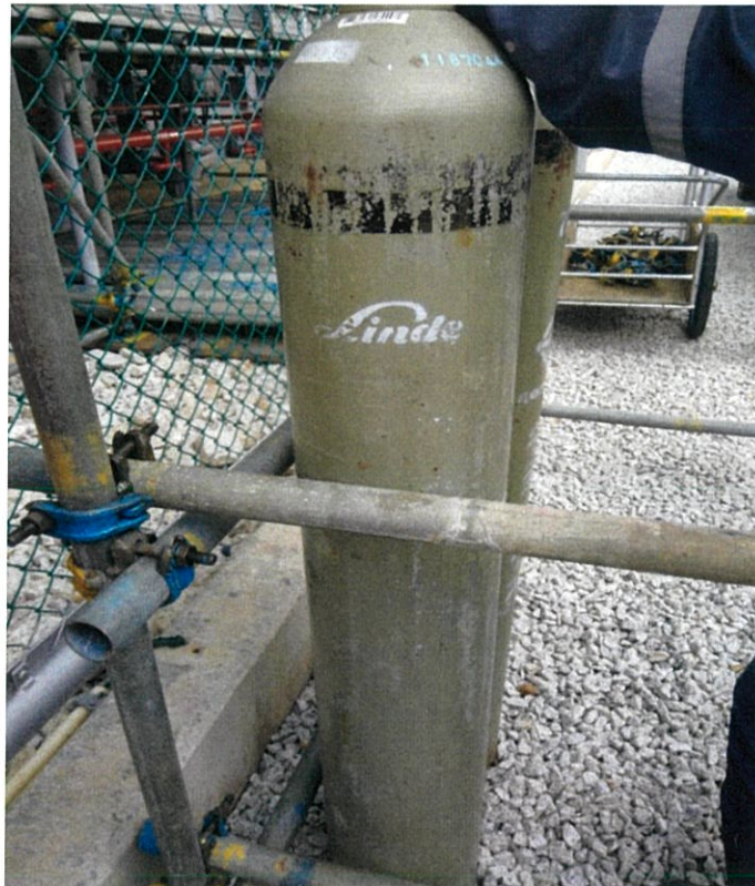
ภาพที่ 4.2 ถังอากาศแห้ง
