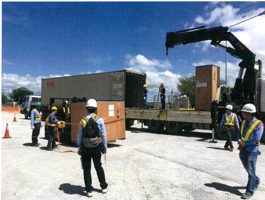
รูปที่ 3.5 การขนย้ายตู้ DCS ใหม่ที่รับมาจากท่าเรือเพื่อนำไปไว้ในที่ที่ใกล้กับที่ติดตั้ง
