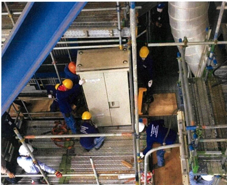
รูปที่ 3.7 ขนย้ายตู้ควบคุมแบบกระจายส่วนอันเก่าออกจากบริเวณที่ติดตั้ง
