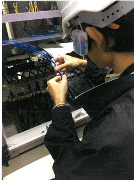
รูปที่ 3.10 การเข้าสายใยแก้วนำแสง
