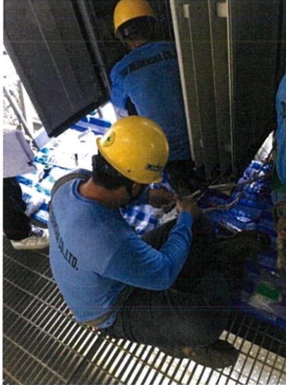
รูปที่ 3.6 ถอดสายสัญญาณออกจากตู้ DCS ตู้เก่า
