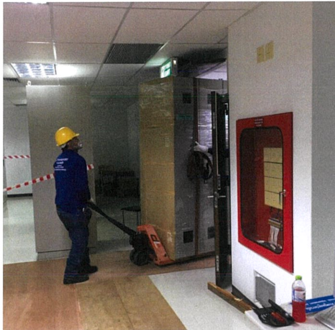
รูปที่ 3.8 ขนย้ายตู้ใหม่เพื่อนำไปติดตั้งแทนตู้เก่าที่ย้ายออกไป
