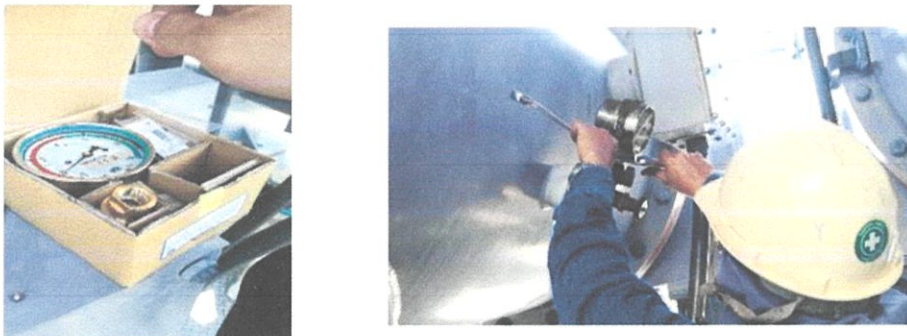
ภาพที่ 4.94 ยืนยันเกจความดันที่จะนำมาเปลี่ยนใหม่ (ซ้าย) , ทำการถอดอันเก่าออก (ขวา)
