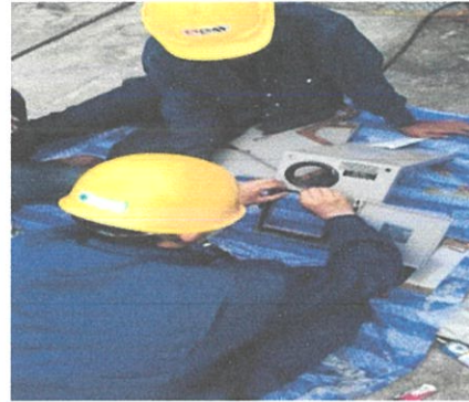
ภาพที่ 4.78 ทำการเปลี่ยนปะเก็น และ O-ring ของฝากล่องการทำงานเชิงกลของ DS/ES/FES
