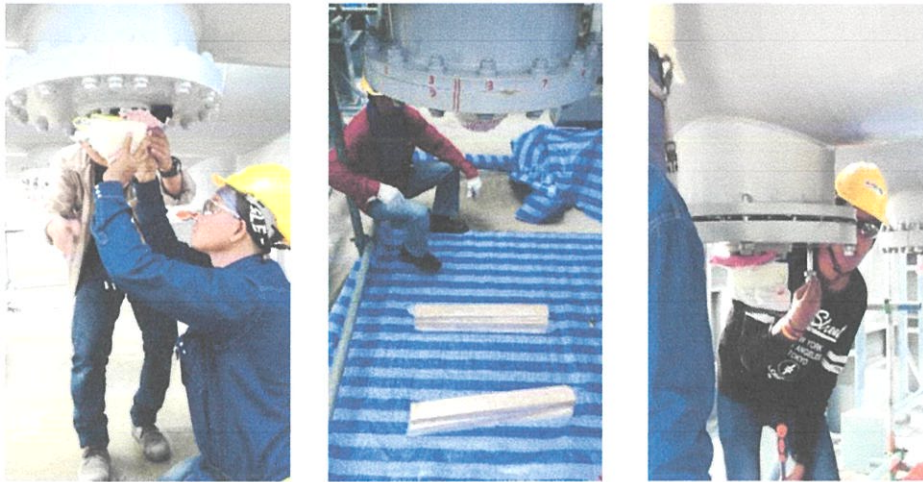
ภาพที่ 4.22 แสดงถึงการเตรียมถอดฝาด้านล่าง(ภาพแรก), วางไม้รองพื้นเพื่อรองรับฝาและกันชูดกับพื้น(ภาพกลาง), ทอยยไขน็อตออก และ เตรียมยกฝาลง(ภาพสาม)
