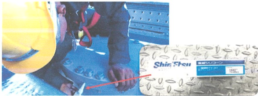
ภาพที่ 4.58 หลังทำการตรวจสอบเช็คก๊าซเรียบร้อยแล้ว ให้ทา Gas sealant (45T) ที่ฝ้าด้านบนและล่าง
