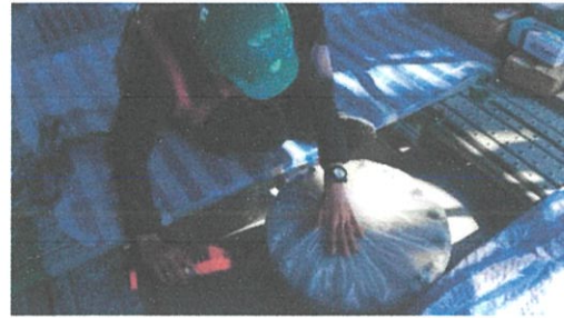
ภาพที่ 4.57 หลังเติมก๊าซเสร็จ ให้คลุมถุงพลาสติกที่ฝ้าด้านบนและล่าง(ซ้าย), ตรวจสอบเช็คก๊าซรั่ว(ขวา)*
