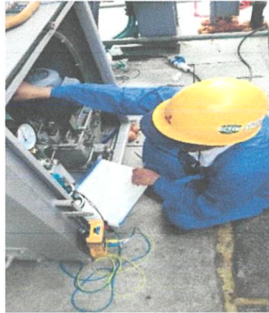
ภาพที่ 4.111 ก่อนทำการทดสอบ ให้ ON CB (ซ้าย)*,ทำการทดสอบ(ขวา)**
