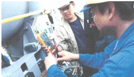
ภาพที่ 4.82 แสดงการตรวจว่าหน้าสัมผัสยังทำงานได้ตามปกติ(ซ้าย), เช็คว่ามีสายใดหลวม(ขวา)
