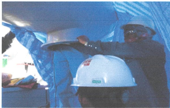
ภาพที่ 4.33 แทนที่ใหม่/ประกอบ stationary arc contact กลับเข้าไป
