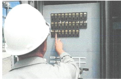
ภาพที่ 4.141 แสดงถึงแผงแจ้งเตือนที่อยู่บน LCP ที่ได้รับการแจ้งเตือนมาจากอุปกรณ์*
