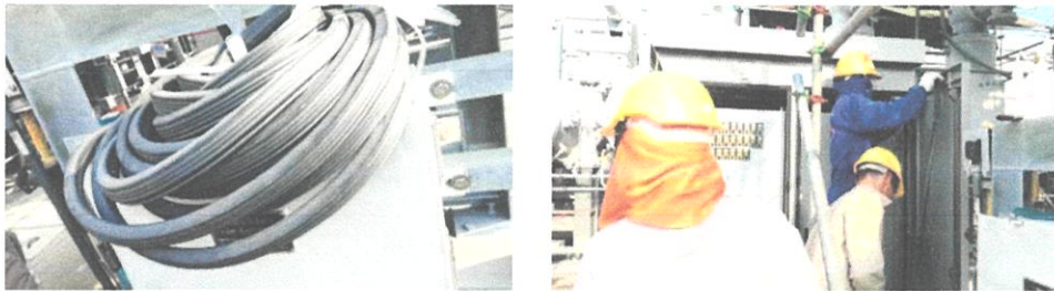
ภาพที่ 4.103 ปะเก็นที่ทำการเปลี่ยน (ซ้าย) , ทำการเปลี่ยนปะเก็นที่ตู้คอนโทรล (LCP) (ขวา)
