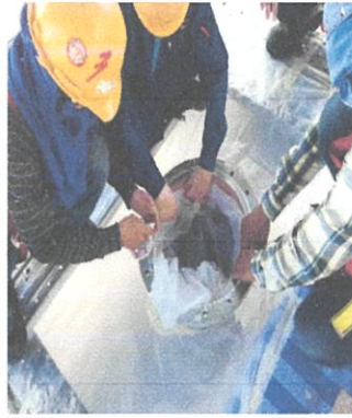
ภาพที่ 4.25 ทำการคลุมถุงพลาสติกกันสกปรกเข้าภายในทั้งฝ้าบนและล่าง
