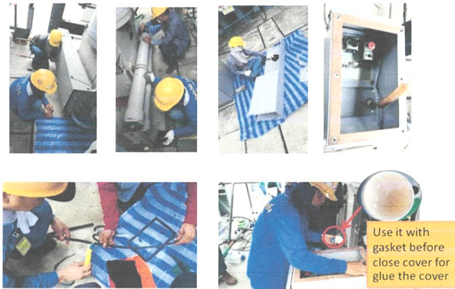
ภาพที่ 4.68 ทำความสะอาด พร้อมเปลี่ยนปะเก็นอุปกรณ์ต่างๆ ใหม่*
