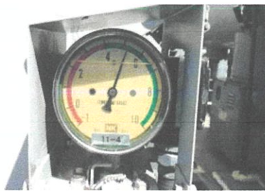
ภาพที่ 4.16 การบันทึกค่าก่อนทำการตรวจสอบ อาทิเช่น ค่าความดันก่อนทำการตรวจสอบ(ภาพแรก) , การจดค่านับการทำงาน(counter) (ภาพสอง) , การจดข้อมูลของตัวอุปกรณ์ (ภาพสาม)*
