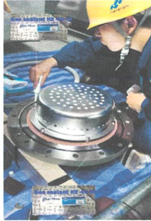
ภาพที่ 4.52 ใช้ lock tile ในการล็อกเกลียว (ซ้าย) , ทำการทา gas sealant (ขวา)*
