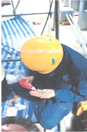
ภาพที่ 4.52 ใช้ lock tile ในการล็อกเกลียว (ซ้าย) , ทำการทา gas sealant (ขวา)*
