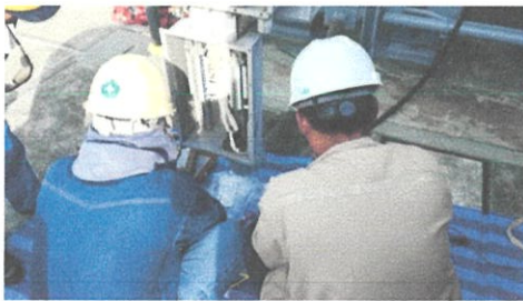
ภาพที่ 4.147 ทำการเช็คกล่องควบคุมเชิงกล และอื่นๆ ว่าไม่มีอุปกรณ์ตกหล่น หรือสายหลวม
