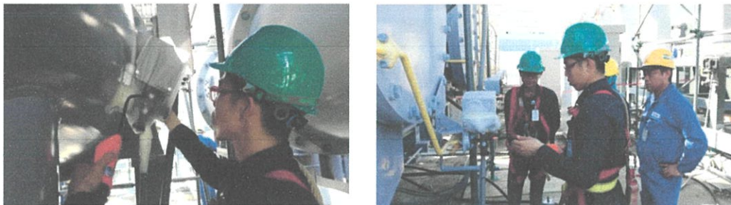
ภาพที่ 4.139 ทำการตรวจวัดก๊าซที่รั่วไหล ตามจุดเกจความดันต่างๆทั้ง VT/DS/CB/Tr Area*
