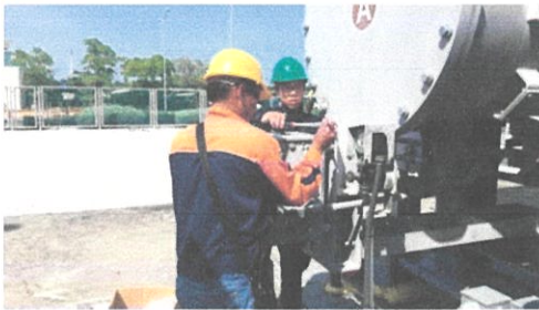
ภาพที่ 4.79 ทำการเปลี่ยนตัวโบลท์ใหม่ ตามรายการที่จัดเตรียมมา
