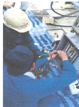
ภาพที่ 4.83 การตรวจสอบฟาด้านล่าง และ เช็คหน้าสัมผัสหรือวงจร ยังทำงานได้ตามปกติ
