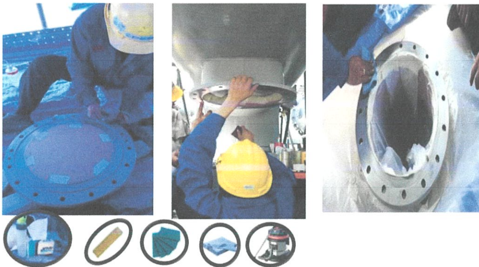
ภาพที่ 4.48 แสดงถึงการทำความสะอาดฝาด้านบน และ ฝาด้านล่าง โดยมีลิสอุปกรณ์ตามภาพ
