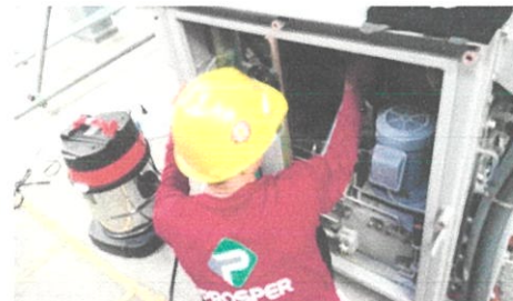
ภาพที่ 4.147 ทำการเช็คกล่องควบคุมเชิงกล และอื่นๆ ว่าไม่มีอุปกรณ์ตกหล่น หรือสายหลวม
