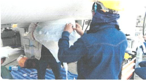
ภาพที่ 4.57 หลังเติมก๊าซเสร็จ ให้คลุมถุงพลาสติกที่ฝ้าด้านบนและล่าง(ซ้าย), ตรวจสอบเช็คก๊าซรั่ว(ขวา)*
