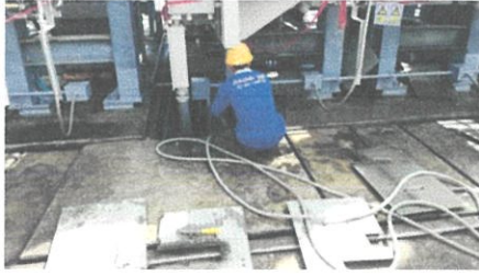
ภาพที่ 4.145 ทำความพื้นทีโดยรอบ และ ทำความสะอาดสายเคเบิลด้านล่าง (ซ้าย) , ทำความสะอาดข้อเชื่อมต่อ G ของ ES (ขวา)
