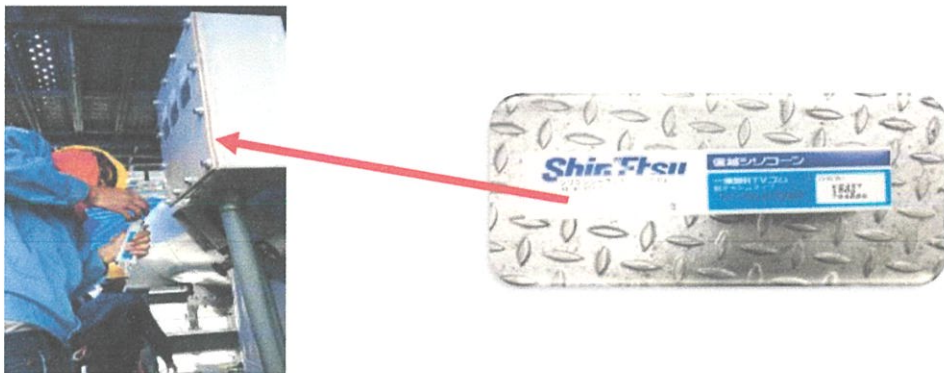
ภาพที่ 4.101 เปลี่ยนตัวโบลท์ใหม่แล้ว ทำการปิดฝา และทาซิลิโคน*
