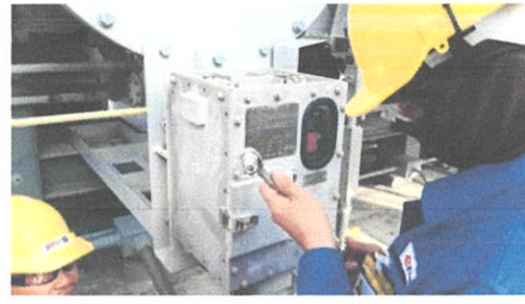
ภาพที่ 4.79 ทำการเปลี่ยนตัวโบลท์ใหม่ ตามรายการที่จัดเตรียมมา
