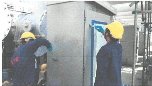
ภาพที่ 4.146 ทำการทาสีที่ตู้คอนโทรล(LCP) แต่ละ Bay
