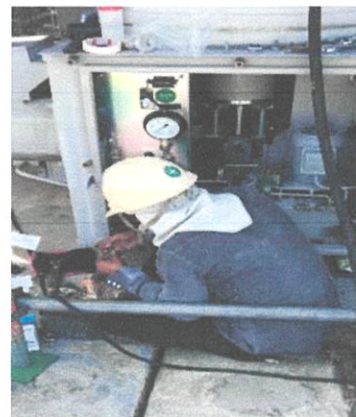
ภาพที่ 4.73 ตรวจสอบสาย และ อุปกรณ์ต่างๆ ว่าไม่มีจุดหลวม หรือ ชิ้นส่วนใดเสียหาย
