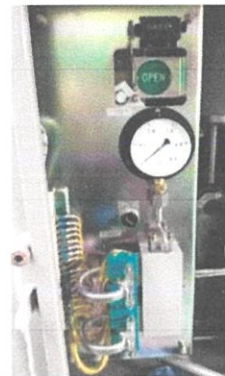
ภาพที่ 4.64 อุปกรณ์ที่นำมาเปลี่ยนใหม่ เช่น ยางป้องกันการสั่นสะเทือน กับ ตัว Nuts ใหม่ (ภาพแรก) , เปลี่ยนเกจวัดความดันใหม่ (ภาพสอง) , หลังทำการเปลี่ยนอุปกรณ์ (ภาพสาม)
