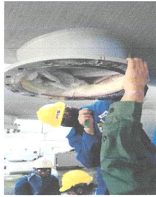
ภาพที่ 4.25 ทำการคลุมถุงพลาสติกกันสกปรกเข้าภายในทั้งฝ้าบนและล่าง
