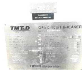
ภาพที่ 4.16 การบันทึกค่าก่อนทำการตรวจสอบ อาทิเช่น ค่าความดันก่อนทำการตรวจสอบ(ภาพแรก) , การจดค่านับการทำงาน(counter) (ภาพสอง) , การจดข้อมูลของตัวอุปกรณ์ (ภาพสาม)*
