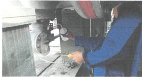
ภาพที่ 4.145 ทำความพื้นทีโดยรอบ และ ทำความสะอาดสายเคเบิลด้านล่าง (ซ้าย) , ทำความสะอาดข้อเชื่อมต่อ G ของ ES (ขวา)
