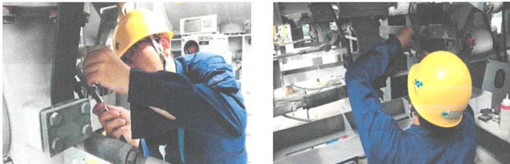
ภาพที่ 4.89 ตัวอย่างการวัดระยะช่องว่าง(Gap) ของอุปกรณ์ DS/ES/FES
