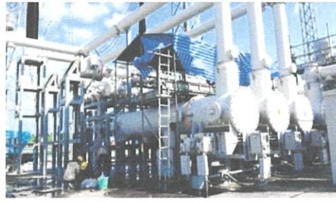
ภาพที่ 4.15 การจัดตั้งนั่งร้านสำหรับเป็นพื้นที่ในการจัดเตรียมอุปกรณ์ (ซ้าย) , นั่งร้านสำหรับตรวจสอบ พร้อมด้วยทำความสะอาดจุดต่างๆ ก่อนทำงานจริง (ขวา)
