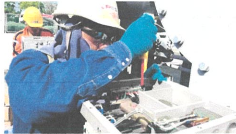
ภาพที่ 4.82 แสดงการตรวจว่าหน้าสัมผัสยังทำงานได้ตามปกติ(ซ้าย), เช็คว่ามีสายใดหลวม(ขวา)
