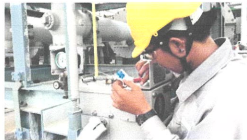
ภาพที่ 4.86 หลังจากทำการตรวจสอบ และเปลี่ยนแล้ว ทำการปิดฝา แล้วmarker(ซ้าย) , ทำการทา gas sealant ที่ทุกฝาของตู้ทำงานเชิงกล เพื่อป้องกันน้ำรั่วเข้า (ขวา)
