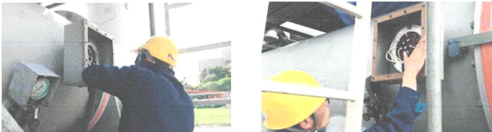
ภาพที่ 4.100 เอาปะเก็นอันเก่าออกแล้วทำความสะอาด(ซ่าย) , ติดกาวยางแล้วเปลี่ยนปะเก็นใหม่ (ขวา)
