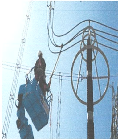
ภาพที่ 4.14 แสดงการวาง Ground cutter สำหรับกรณี Bay ที่ส่งจ่ายออกสู่ภายนอก (ซ้าย), แสดงการติดเทปบ่งบอกถึงจุดที่มีไฟและทำการCloseเอาไว้ในช่วงซ่อมบำรุงนี้ (ขวา)
