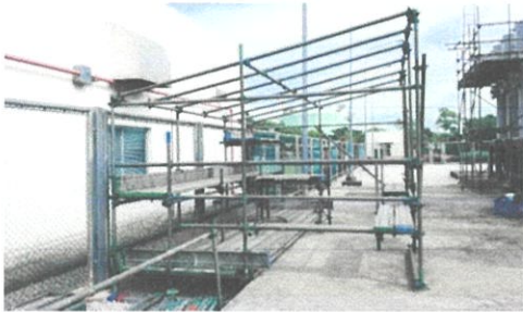
ภาพที่ 4.15 การจัดตั้งนั่งร้านสำหรับเป็นพื้นที่ในการจัดเตรียมอุปกรณ์ (ซ้าย) , นั่งร้านสำหรับตรวจสอบ พร้อมด้วยทำความสะอาดจุดต่างๆ ก่อนทำงานจริง (ขวา)
