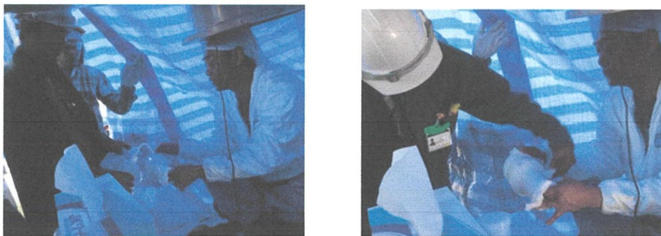
ภาพที่ 4.37 ทำความสะอาดตัว Nozzle อันใหม่ก่อนทำการติดตั้งกลับ ***
