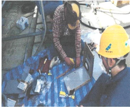
ภาพที่ 4.78 ทำการเปลี่ยนปะเก็น และ O-ring ของฝากล่องการทำงานเชิงกลของ DS/ES/FES
