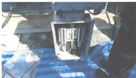
ภาพที่ 4.83 การตรวจสอบฟาด้านล่าง และ เช็คหน้าสัมผัสหรือวงจร ยังทำงานได้ตามปกติ
