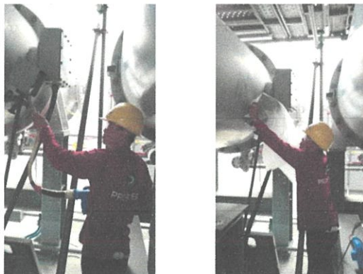
ภาพที่ 4.137 เป่าลมบริเวณที่เติมก๊าซเสร็จ(ซ้าย), คลุมด้วยพลาสติก(ขวา)*
