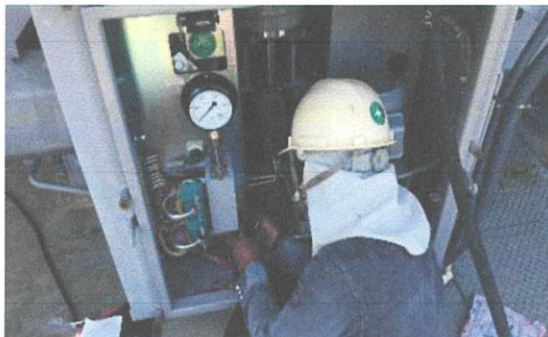
ภาพที่ 4.73 ตรวจสอบสาย และ อุปกรณ์ต่างๆ ว่าไม่มีจุดหลวม หรือ ชิ้นส่วนใดเสียหาย
