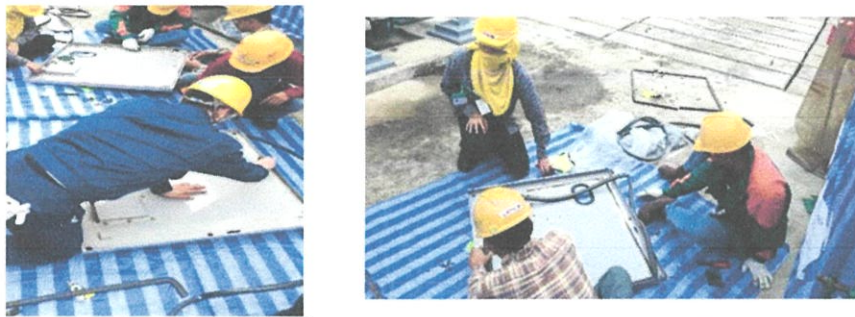
ภาพที่ 4.67 ทำการเปลี่ยน O-ring ของฝากรอบใหม่ ด้วยการติดกาวยาง
