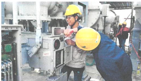
ภาพที่ 4.86 หลังจากทำการตรวจสอบ และเปลี่ยนแล้ว ทำการปิดฝา แล้วmarker(ซ้าย) , ทำการทา gas sealant ที่ทุกฝาของตู้ทำงานเชิงกล เพื่อป้องกันน้ำรั่วเข้า (ขวา)
