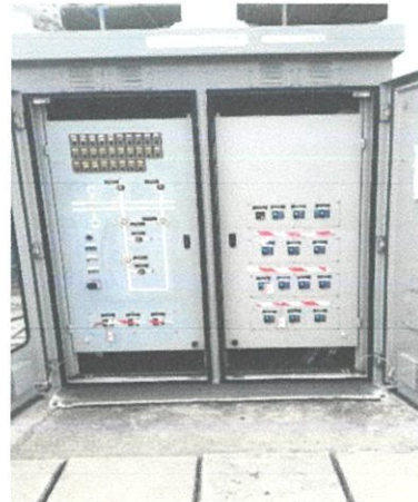
ภาพที่ 4.14 แสดงการวาง Ground cutter สำหรับกรณี Bay ที่ส่งจ่ายออกสู่ภายนอก (ซ้าย), แสดงการติดเทปบ่งบอกถึงจุดที่มีไฟและทำการCloseเอาไว้ในช่วงซ่อมบำรุงนี้ (ขวา)
