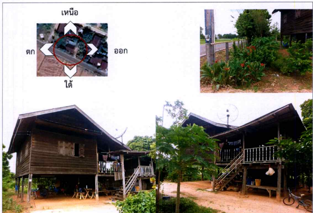
รูปที่ 4.9 แสดงทิศทางการตั้งเรือน, และลักษณะทางสถาปัตยกรรม [H03]
