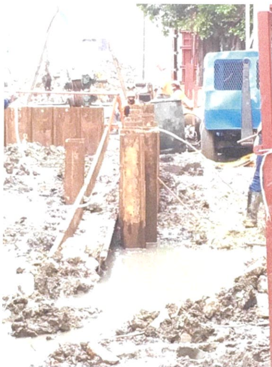
ภาพที่ 3.3 แสดงการจัดวางเข็มพืดเหล็กให้ตรงแนวร่อง Interlocking
