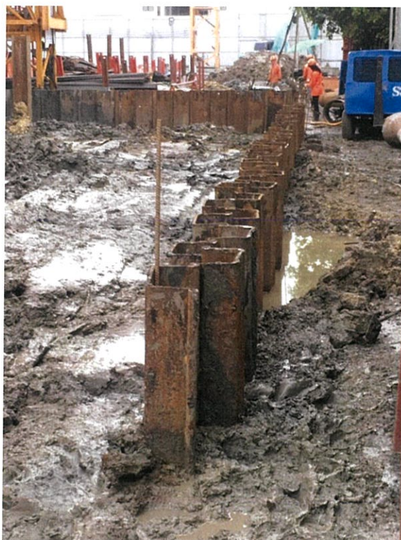
ภาพที่ 3.1 แสดงการขุดหน้าดินและการจัดทำ Leg Guide
