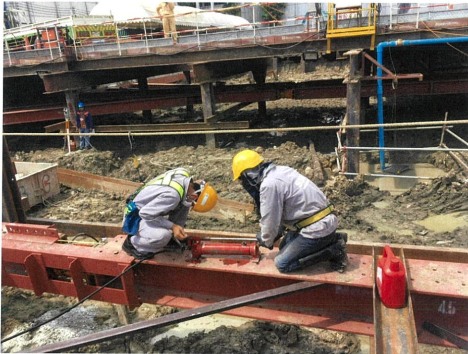
ภาพที่ 3.12 ภาพการตรวจสอบการรั่วซึมของน้ำมัน Hydraulic
