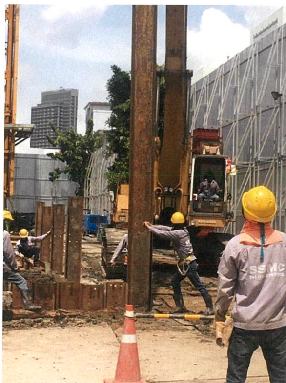
ภาพที่ 3.2 แสดงการปักเข็มพืดเหล็ก
