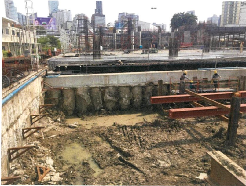
ภาพที่ 3.6 แสดงการติดตั้ง Bracket และ Wale
