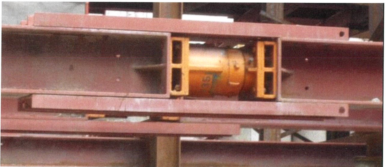
ภาพที่ 3.15 รูปแสดงการจบการ Pre-Load
