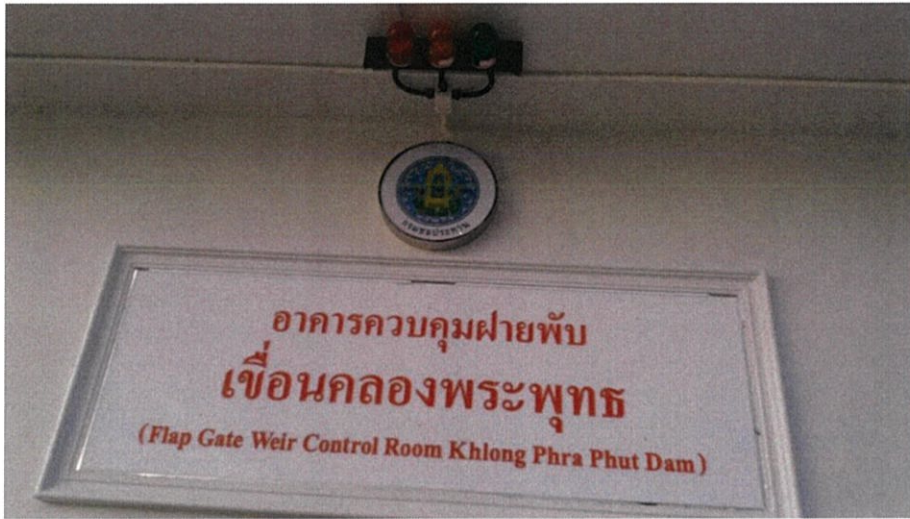
ภาพที่ 3.69 การติดตั้งระบบสัญญาณไฟเตือนภัยระดับน้ำ
