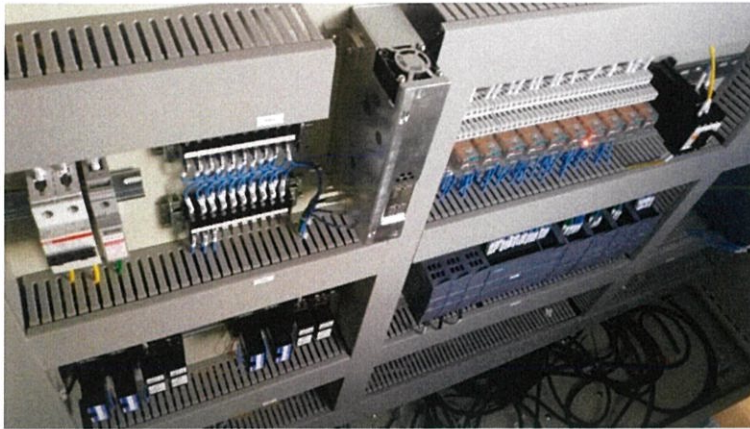
ภาพที่ 3.73 การวาง Lay out และการเชื่อมต่ออุปกรณ์ทั้งหมดเข้าด้วยกัน
