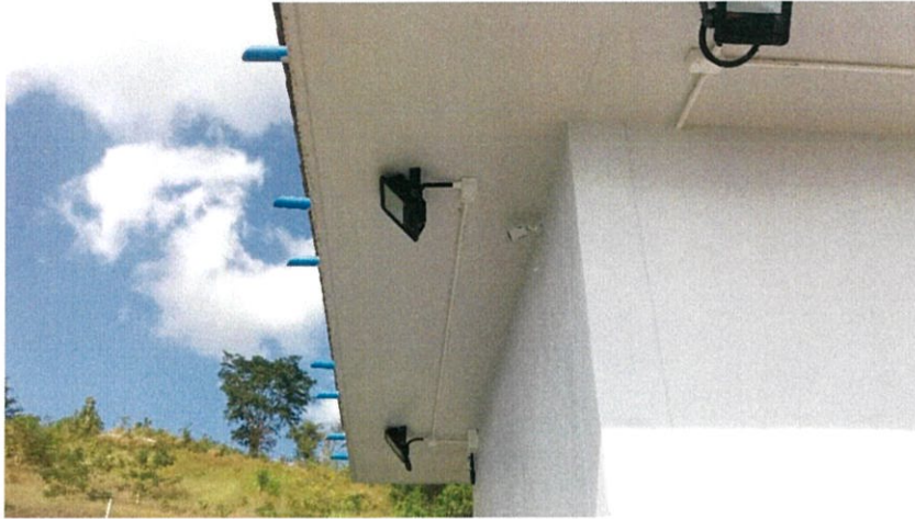
ภาพที่ 3.71 การติดตั้งกล้อง CCTV
