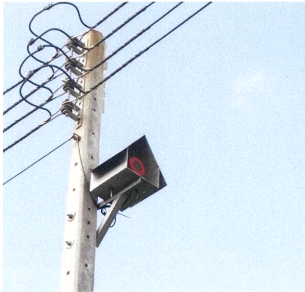
ภาพที่ 3.70 การติดตั้งระบบสัญญาณไซเรนเตือนภัยระดับน้ำ
