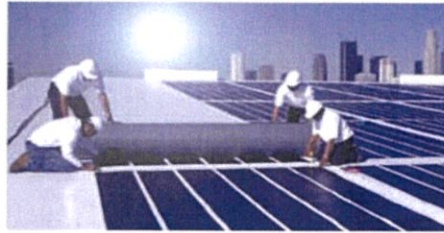
รูปที่ 2.18 แผงเซลล์แสงอาทิตย์แบบอ่อนตัว
