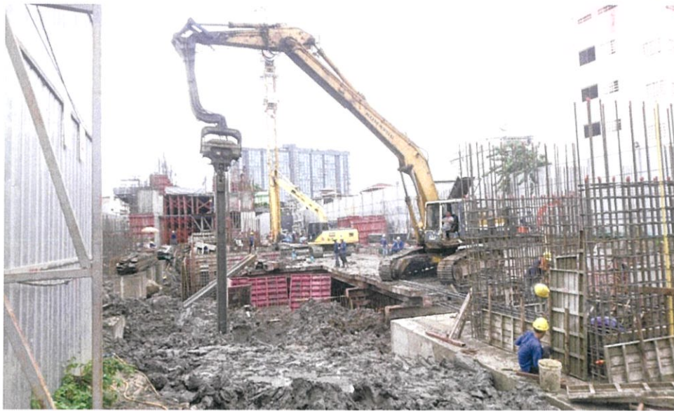
ภาพที่ 4.37 แสดงงานรื้อถอน king Post
