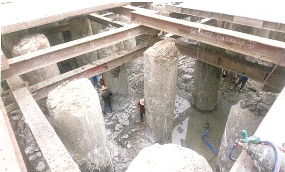
ภาพที่ 4.28 แสดงงานตัดหัวเข็มภายในบ่อเพื่อทำงานฐานราก
