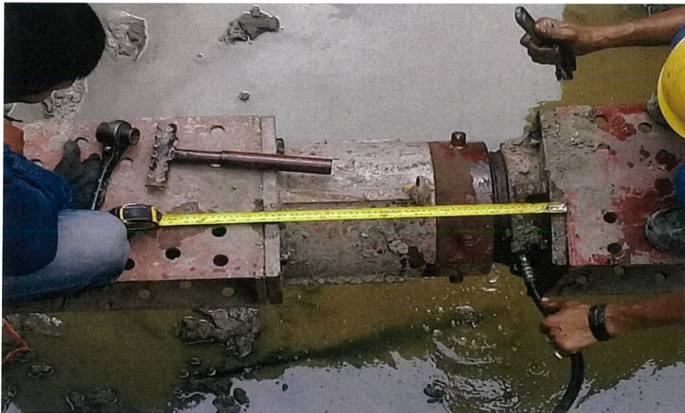
ภาพที่ 4.26 แสดงงาน Preload
