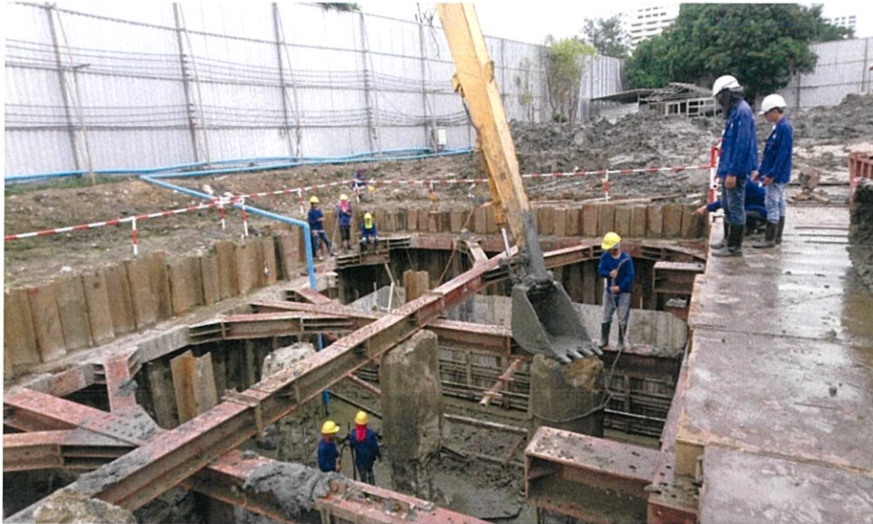
ภาพที่ 4.27 แสดงงานขุดดินครั้งที่ 2 ถึงระดับที่จะทำงานฐานราก
