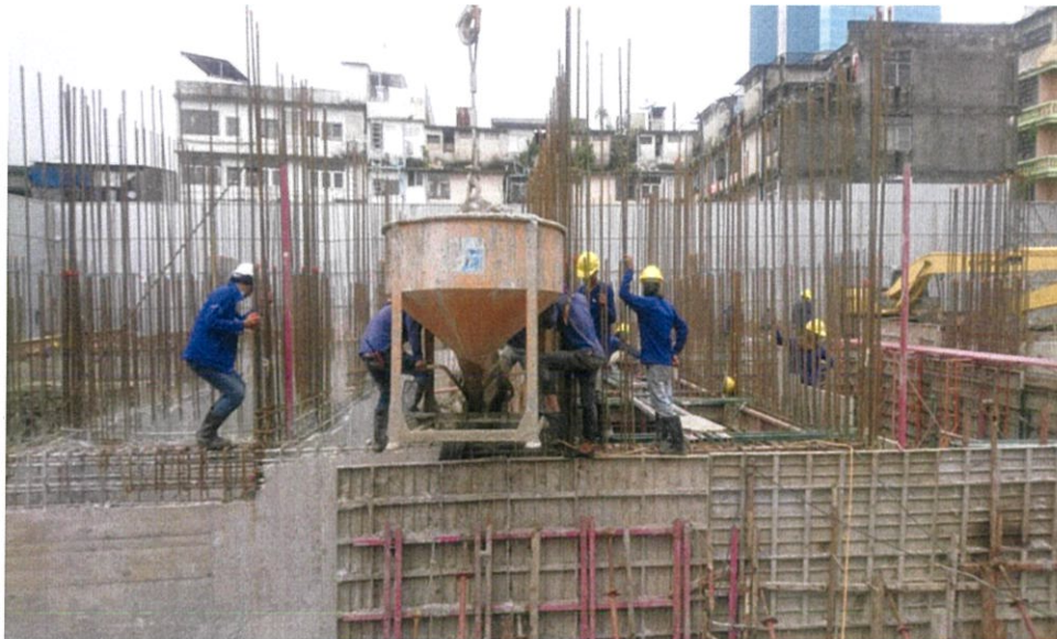
ภาพที่ 4.34 แสดงงานเทคอนกรีตผนังบ่อน้ำดี
