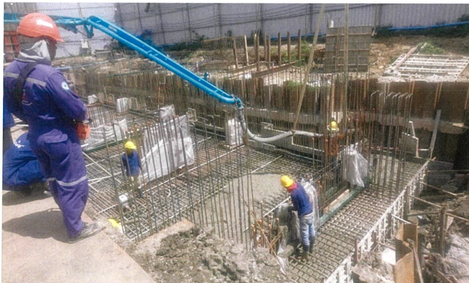
ภาพที่ 4.32 แสดงงานเทพื้นบ่อน้ำใต้
