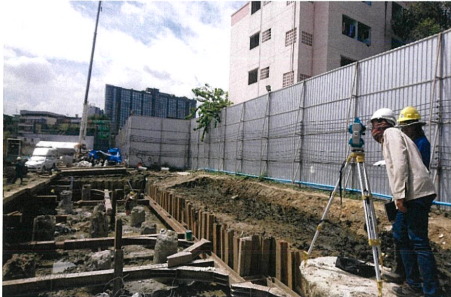
ภาพที่ 4.39 แสดงการตรวจวัดการเคลื่อนตัวของระบบกำแพงกันดิน
