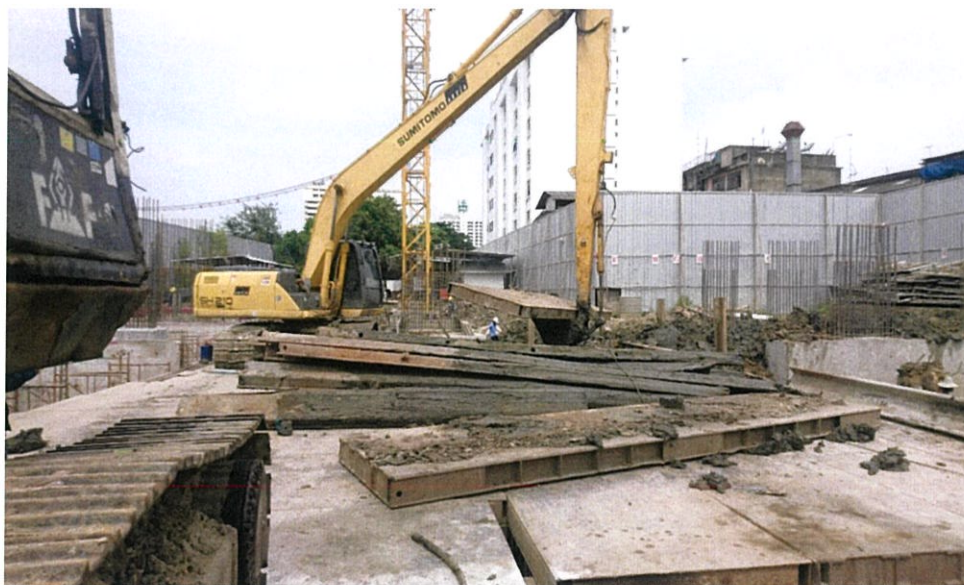
ภาพที่ 4.36 แสดงงานรื้อถอนสะพานชั่วคราว
