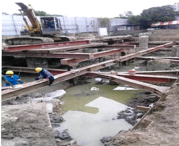
ภาพที่ 4.24 แสดงการติดตั้งค้ำยัน
