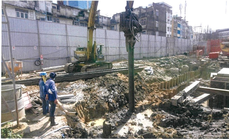
ภาพที่ 4.35 แสดงงานรื้อถอน Sheet Pile
