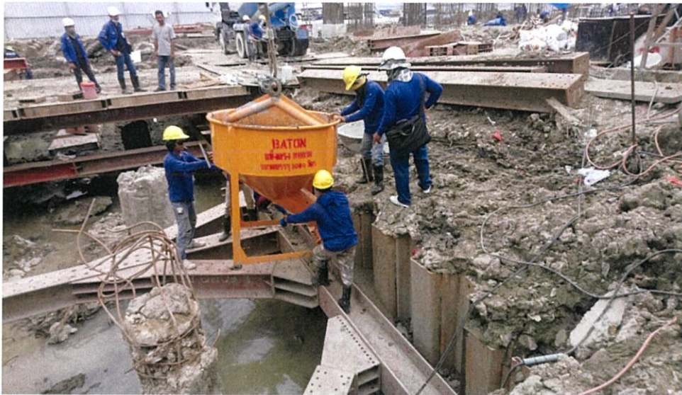
ภาพที่ 4.25 แสดงงานเท lean คอนกรีต หลัง Wale และร่อง Wale
