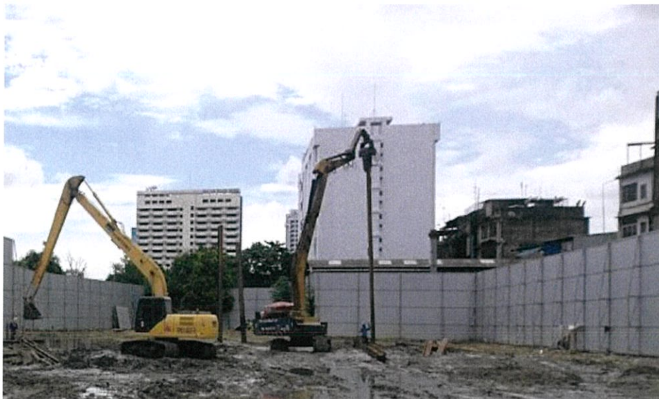
ภาพที่ 4.19 แสดงงานตอก Sheet Pile
