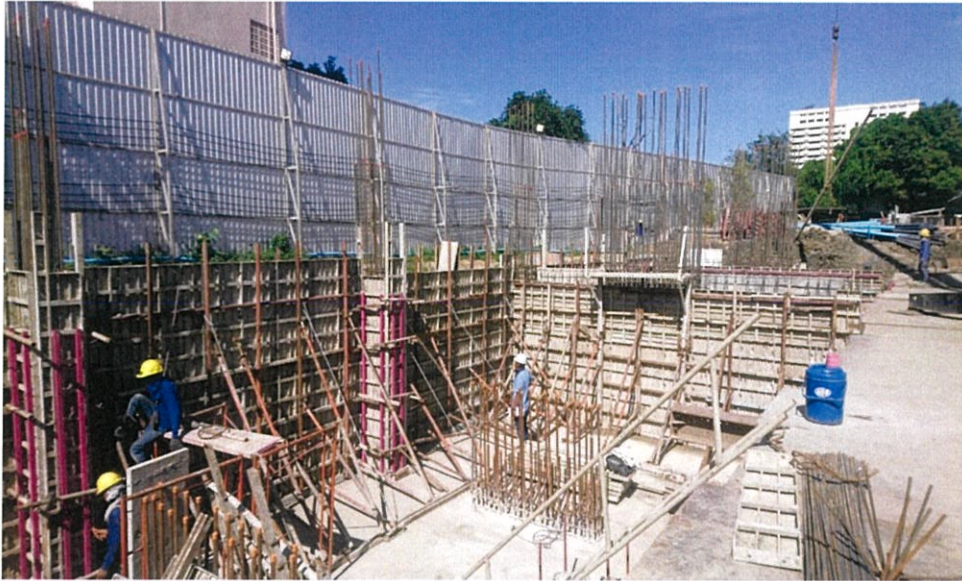
ภาพที่ 4.33 แสดงการติดตั้งค้ำยันแบบเทคอนกรีตผนังบ่อน้ำดี
