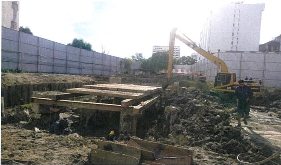
ภาพที่ 4.23 ภาพแสดงการติดตั้ง Support และ สะพานชั่วคราว
