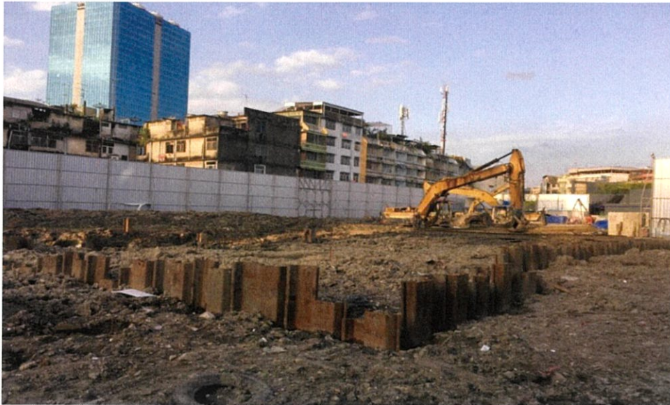
ภาพที่ 4.21 แสดงแนวการตอก Sheet Pile
