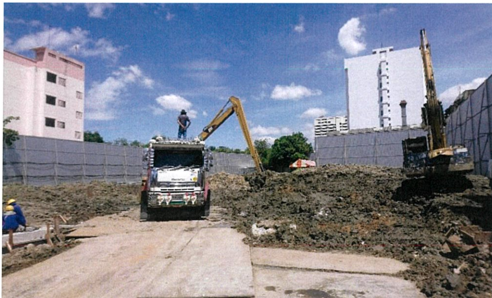
ภาพที่ 4.18 แสดงงานขุดดิน
