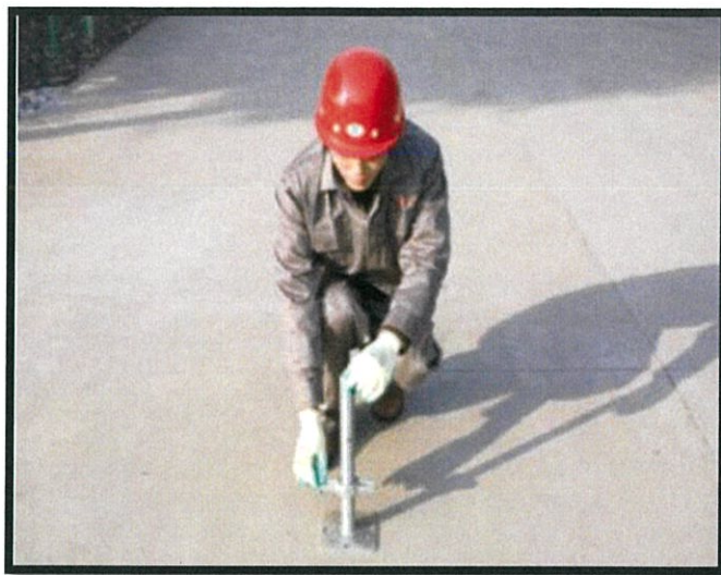
ภาพที่ 3.10 นำ Jack Base มาเตรียม
