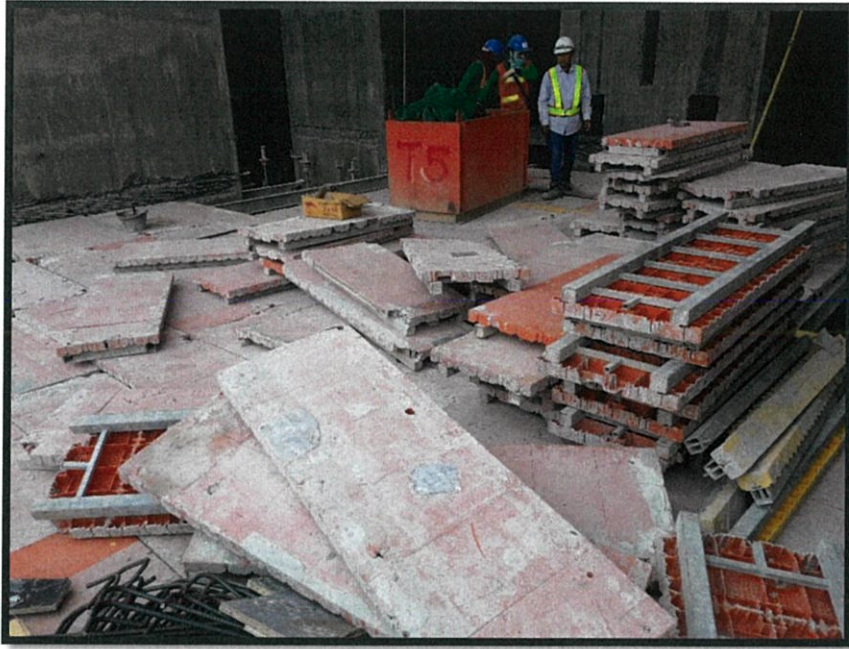
ภาพที่ ก.3 แผ่น Fuvi ที่กำลังเตรียมเพื่อใช้งานในการปูเป็นพื้น
