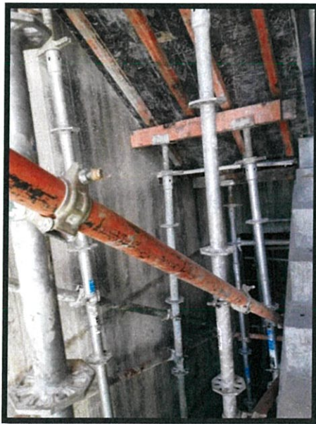
ภาพที่ 3.6 ต่อข้อต่อเหล็กเพื่อยึดนั่งร้านเข้าด้วยกัน
