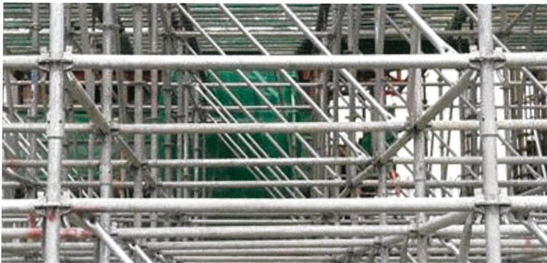
ภาพที่ 2.16 Ring Lock Ledger (horizontal)
