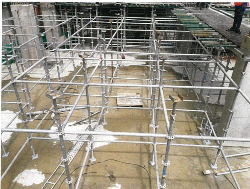
ภาพที่ 2.14 นั่งร้านแบบท่อและข้อต่อ (Wuxi)
