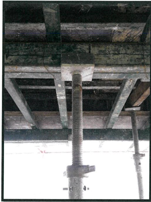
ภาพที่ 3.5 นำ U-head ประกอบเข้ากับเฟรม
