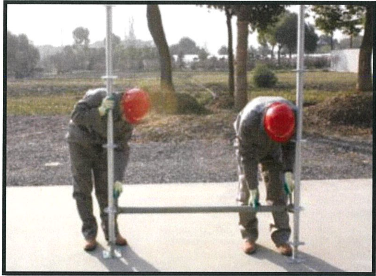
ภาพที่ 3.12 ติดตั้ง Ring Lock Ledger (horizontal)
