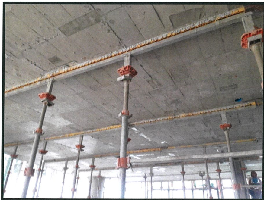
ภาพที่ ก.6 หลังจากเทพื้นเสร็จจะมีค้ำยันเพื่อให้คอนกรีตพัฒนากำลังได้อย่างเต็มที่ หลังจากนั้นค่อยนำค้ำยันออกได้
