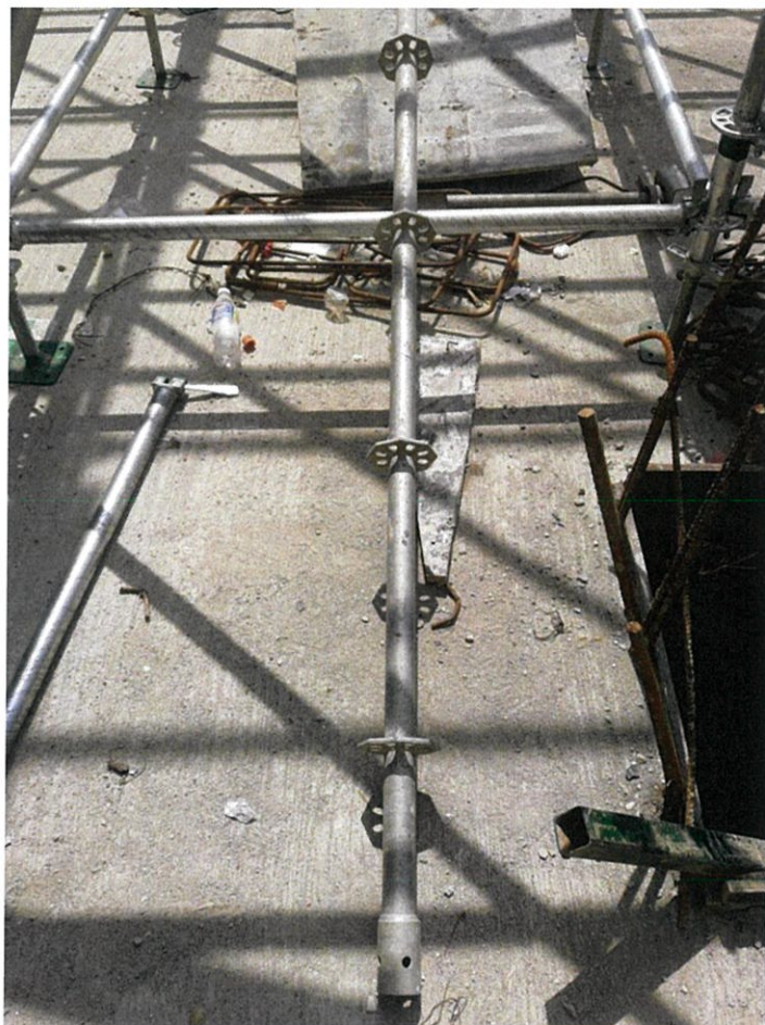
ภาพที่ 2.15 Ring Lock Standard (vertical)
