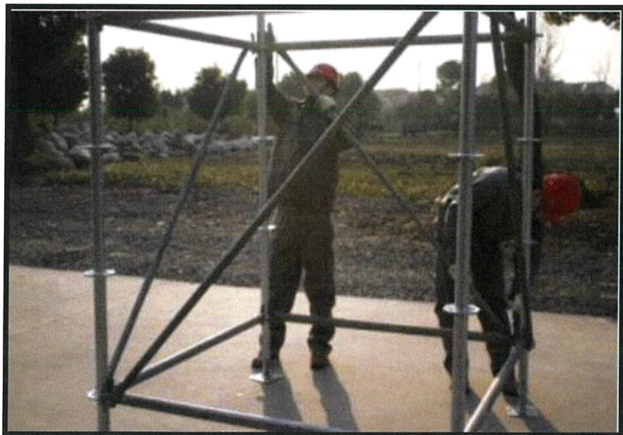
ภาพที่ 3.15 ติดตั้ง Ring Lock Brace (แนวทแยง) ทั้งสี่ด้าน
