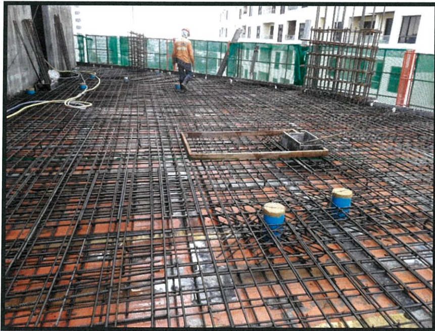
ภาพที่ ก.4 แผ่น Fuvi ที่เสร็จแล้ว สามารถทำงานอื่นๆต่อไปได้ เช่น ลงเหล็ก เทคอนกรีตเป็นต้น
