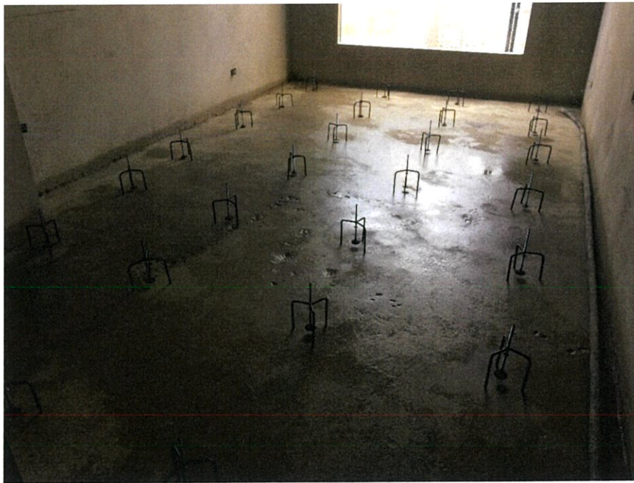
4. ตั้งระดับการเทโดยใช้เครื่องตั้งระดับปุ่ม
