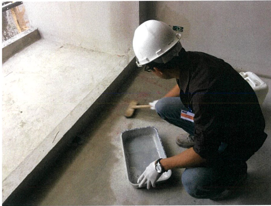
3. ลงน้ำยาประสานคอนกรีต ทิ้งไว้ 1-2 ชั่วโมง
