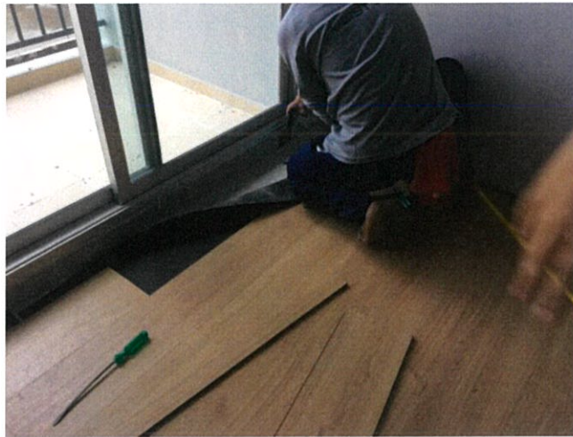
ภาพที่ 3.5 แสดงการแก้ไขพื้นไม้ลามิเนตกรณียุบตัวมาก
