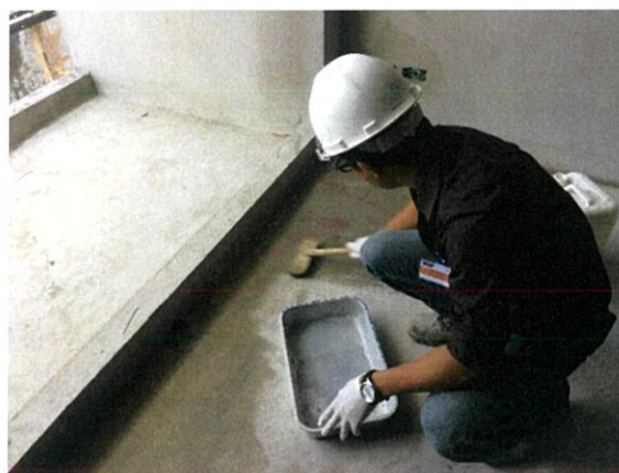
5. ลงน้ำยาคอนกรีตทิ้งไว้ 1-2 ชม.
