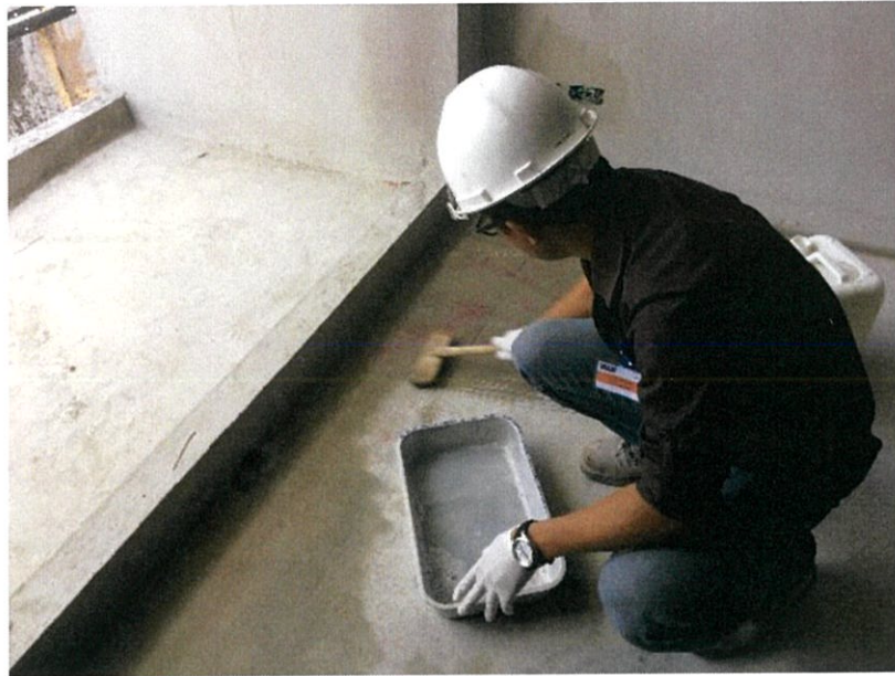
5.ลงน้ำยาคอนกรีตทิ้งไว้ 1-2 ชม.
