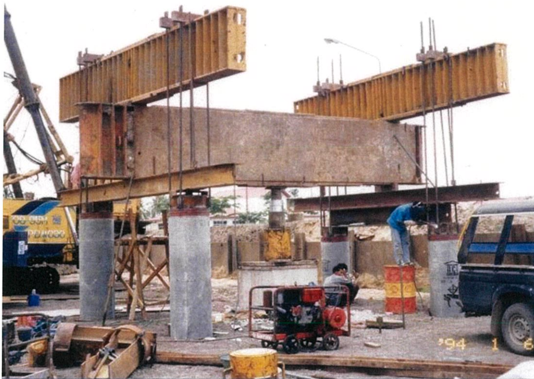
รูปที่ 2.8 ภาพการทดสอบเสาเข็มโดยใช้ Anchor pile (ขนาดล คงสมบูรณ์, ม.ป.ป.)
