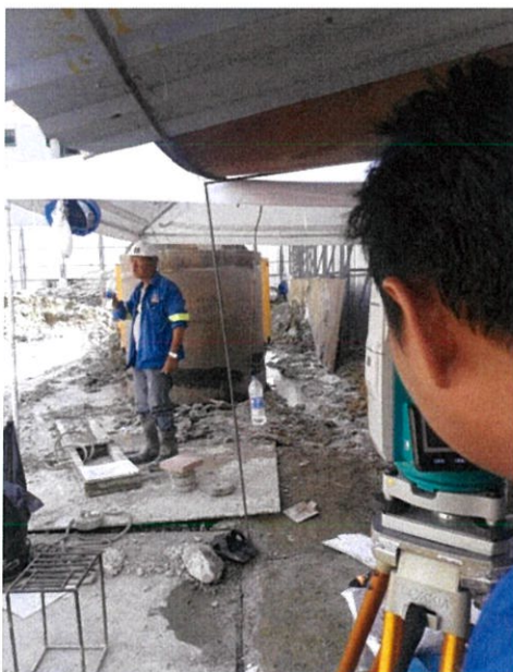
รูปที่ 4.12 นักสำรวจกำลังสอบจุดตั้งกล้อง
