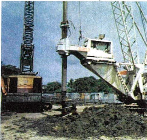
5) การเจาะดินด้วยหัวเจาะแบบสว่าน
