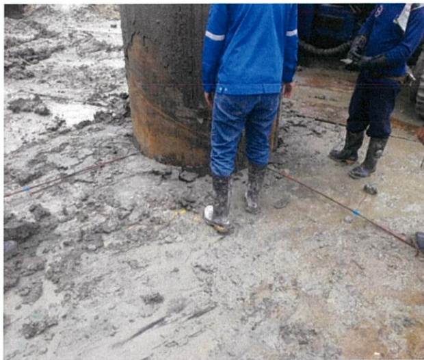
รูปที่ 4.15 การควบคุมการเคลื่อนตัวทางแนวราบของเสาเข็ม รูปที่ 4.16 การตรวจสอบตั้งของปลอกเหล็ก
