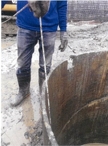
รูปที่ 4.20 การตรวจสอบความลึกหลุมเจาะ
