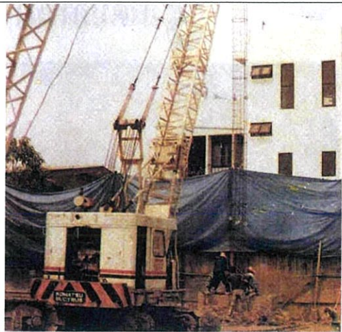
8) ใส่กรงเหล็กเสริมเสาเข็ม
