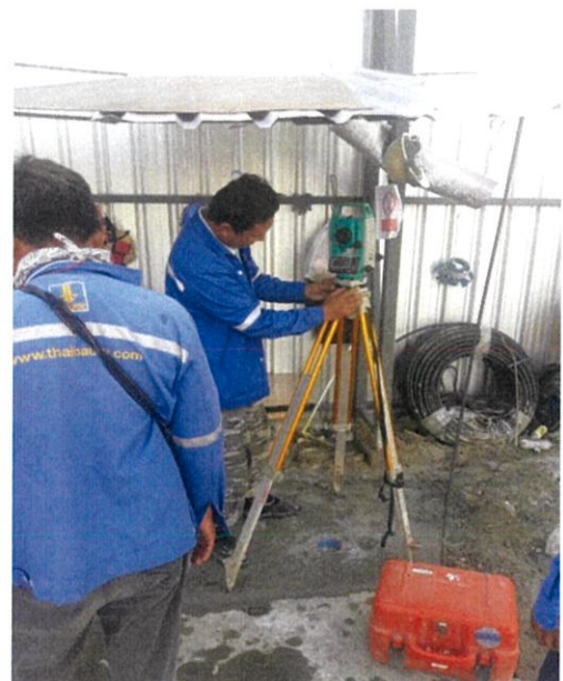
รูปที่ 4.13 การตรวจสอบการตั้งกล้อง
