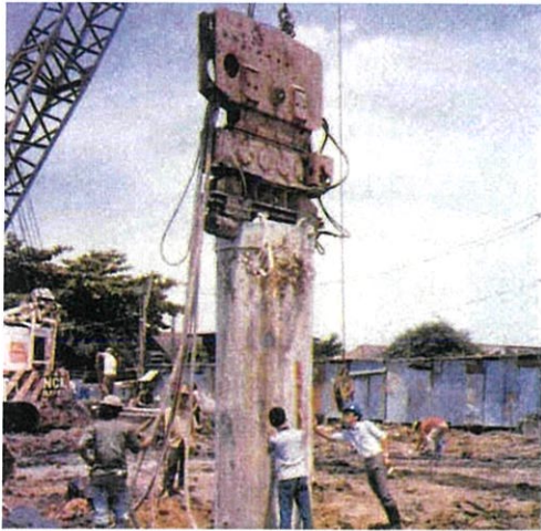
1) กดปลอกเหล็กชั่วคราวก่อนเจาะดิน
