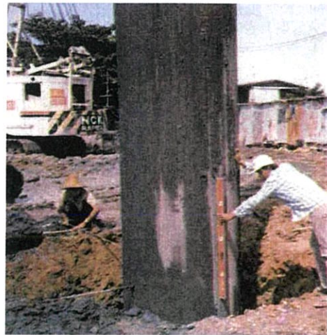
2) ตรวจสอบแนวตั้งของปลอกเหล็ก
