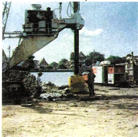
6) การใช้หัวเจาะแบบถัง ในชั้นดินแข็งหรือชั้นทราย
