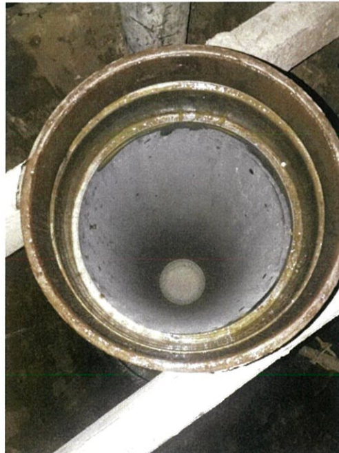
รูปที่ 4.24 วัสดุแบ่งที่ถูกลงไปลงในท่อเทคอนกรีต
