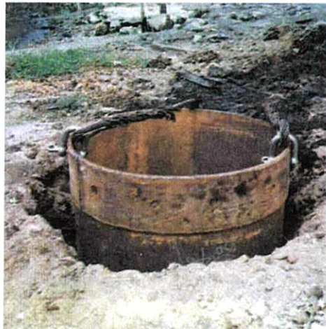
4) ปลอกเหล็กชั่วคราวที่ถูกกดลงในดินแล้ว
