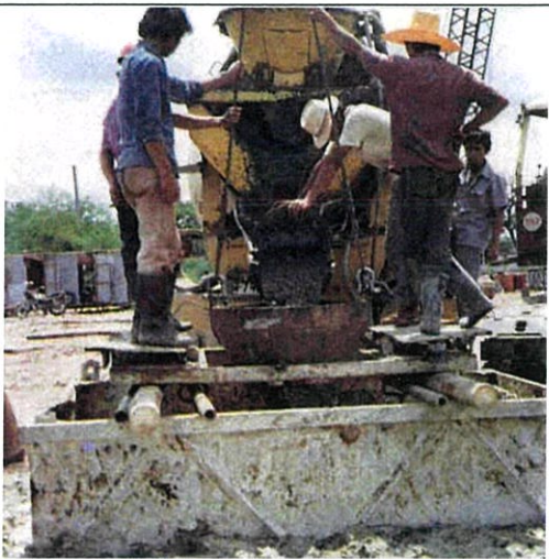
10) เทคอนกรีตใส่สารละลายเบนโทไนท์
