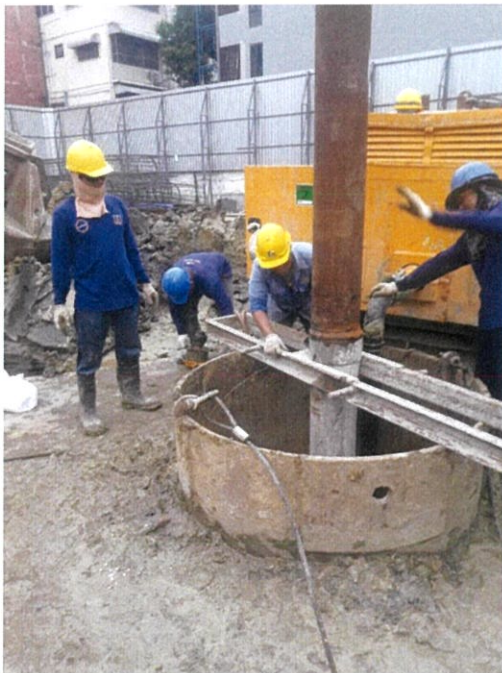
รูปที่ 4.23 การลงท่อเทคอนกรีต
