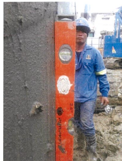
รูปที่ 4.15 การควบคุมการเคลื่อนตัวทางแนวราบของเสาเข็ม รูปที่ 4.16 การตรวจสอบตั้งของปลอกเหล็ก
