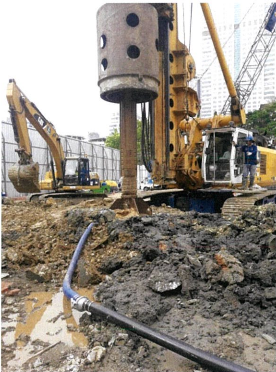
รูปที่ 4.17 การขุดเจาะในชั้นดินอ่อน
