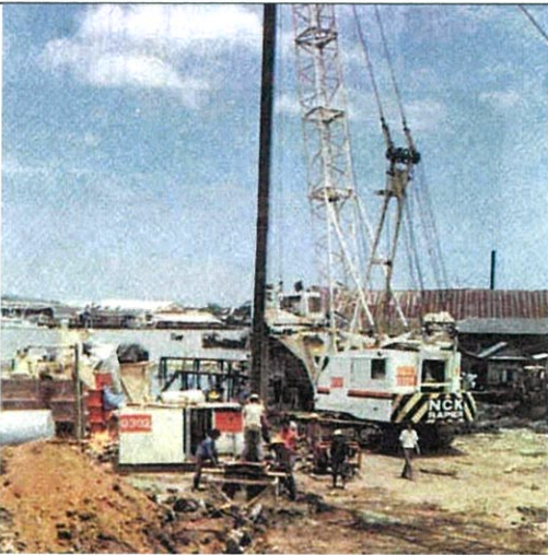
9) ใส่ท่อเทคอนกรีต
