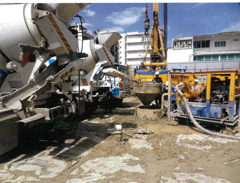
รูปที่ 4.29 การเทคอนกรีตเสาเข็มเจาะ
