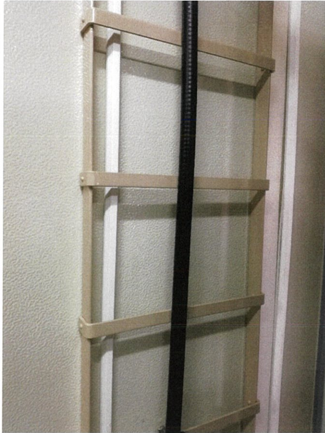
รูปที่ 3.11 สายส่งสัญญาณ ขนาด 1-5/8 นิ้ว
