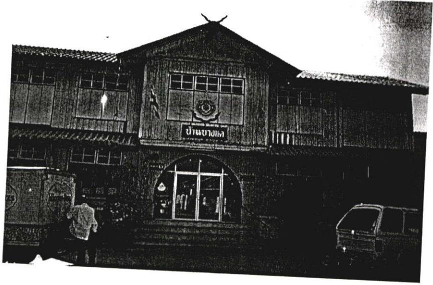
ภาพที่ 4.8 แสดงอาคารสำนักงานเป็นอาคารไม้ 2 ชั้น
