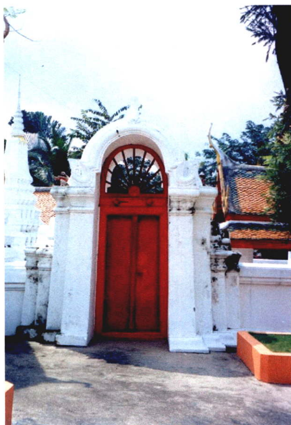
ภาพที่ 4.18 ซุ้มประตูกำแพงแก้ว ตัวบานประตูทาสีใหม่ทับลายแกะสลักที่อกเสาโดยปรากฏการปิดทองประดับกระจกในของเดิม
