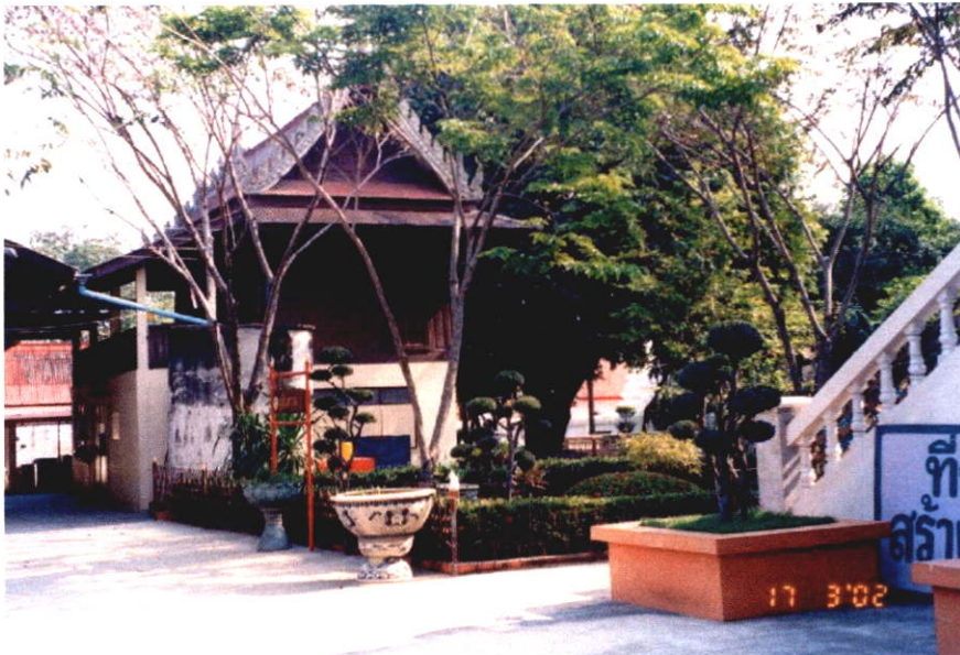
ภาพที่ 4.43 กุฎิผู้ปกครองวัดองค์ก่อนเป็นอาคารไม้ชั้นเดียวได้ถูกสูงก่อผนังโดยรอบ
