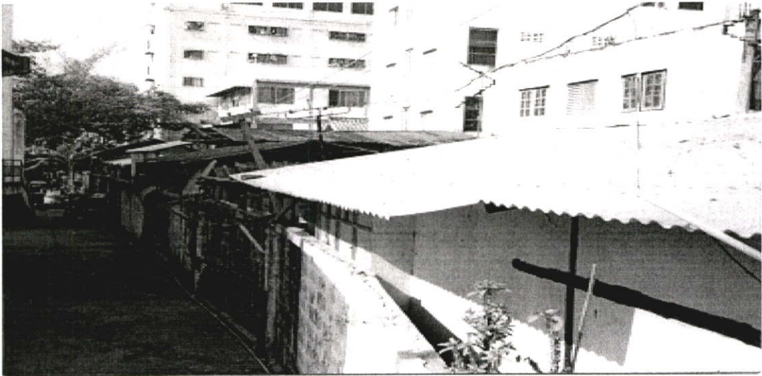
ภาพที่ 4.2 บ้านในโซนที่2 มีลักษณะสร้างเรียงกันเป็นแถวอยู่ระหว่าง อพาร์ทเมนต์กับโรงหนัง เพชรคลองจั่น(ปัจจุบันเป็นสถานบันเทิงนีโอสแควร์)
