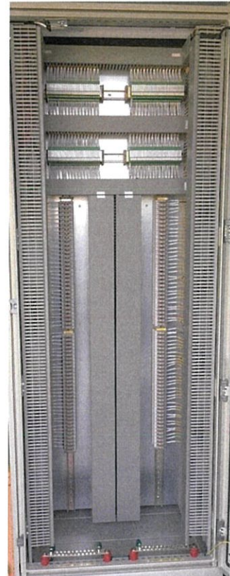
รูปที่ 3.16 Layout ด้านหลังตู้ IRP สำหรับส่ง Signal ไป Start มอเตอร์
