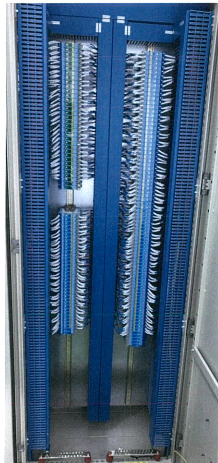
รูปที่ 3.9 Layout ด้านหลังตู้ Marshalling 1
