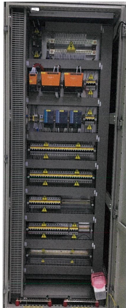
รูปที่ 3.6 Layout ตู้ไฟฟ้า (Power Distribution Panel; PDP)
