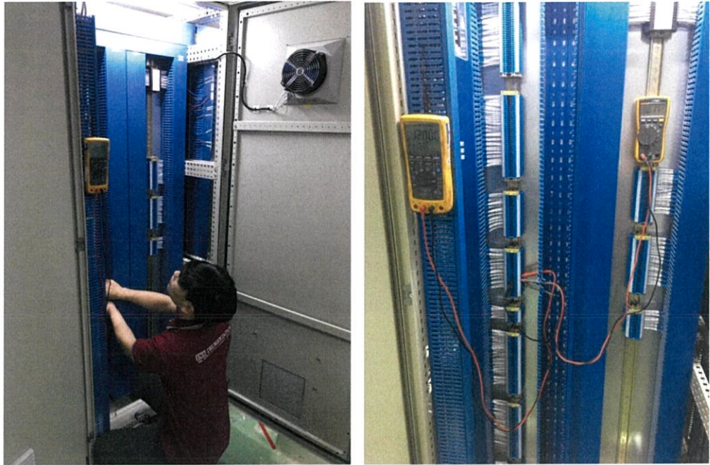
รูปที่ 4.1 การ Simulation แทนอุปกรณ์จากหน้างาน
