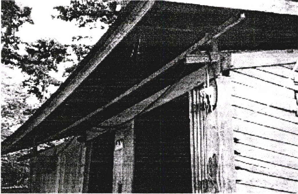
ภาพที่ 2.21 แสดงสายไฟฟ้าที่มีลักษณะหย่อนๆ นั้น เนื่องจากการเผื่อการลอยตัวของตัวบ้าน และการใช้สะพานไฟแบบสมัยเก่า (จ.สุราษฎร์ธานี ถ่ายเมื่อวันที่ 23 มีนาคม พ.ศ. 2544)
