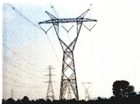
รูปที่ 4.1 ลักษณะเสาโครงเหล็กของสายส่งไฟฟ้าแรงสูง 500 kV ชนิดวงจรเดี่ยวและวงจรคู่
