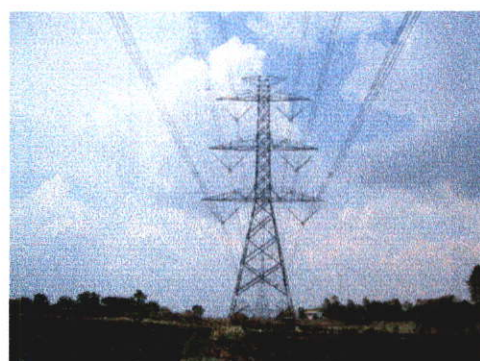
รูปที่ 4.1 ลักษณะเสาโครงเหล็กของสายส่งไฟฟ้าแรงสูง 500 kV ชนิดวงจรเดี่ยวและวงจรคู่
