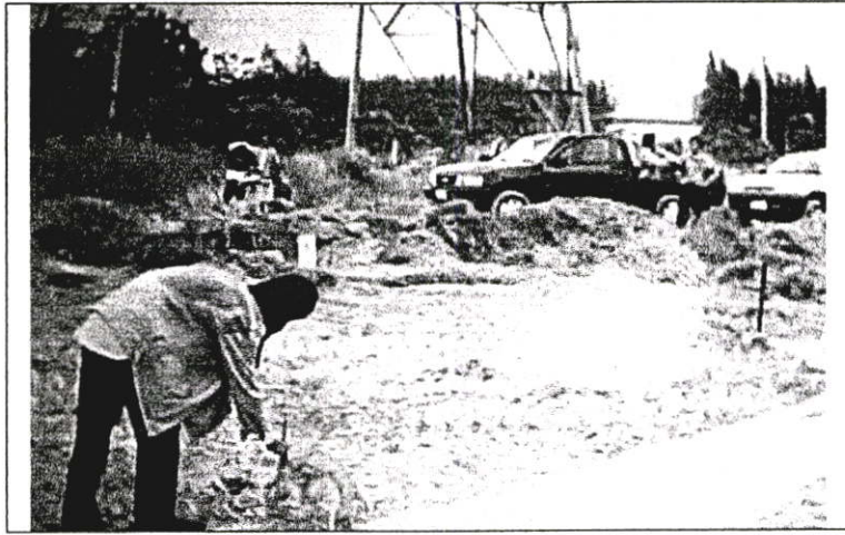
รูปที่ 4.57 การติดตั้งกราวด์รูดที่ใช้วัดแรงดันเหนี่ยวนำ
