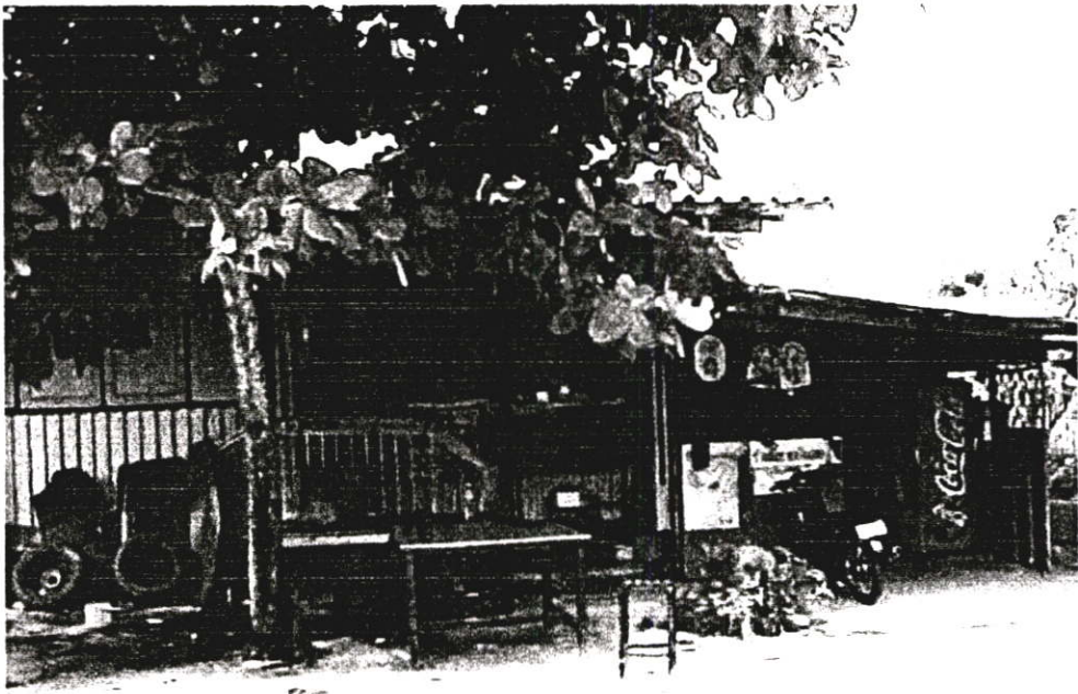
รูปด้านหน้าอาคารพักอาศัย แบบเรือนแถว
