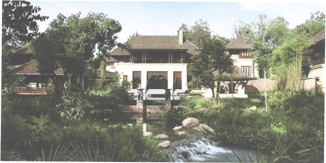
ภาพที่ 4.2.13 อาคารพักอาศัย โรงแรมโพธิ์ศรีชั้น เชียงใหม่
