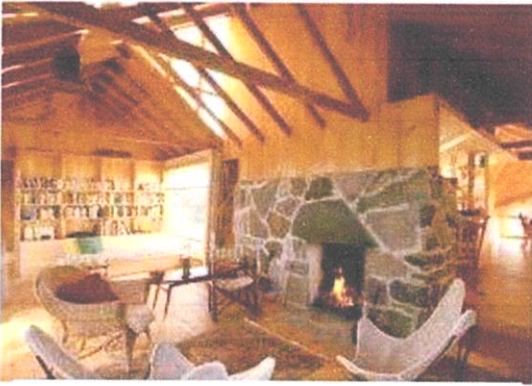
โชว์โครงสร้างหลังคาไม้เพื่อความสวยงามในอาคาร
