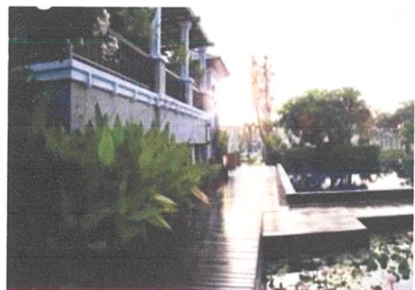
การปูพื้นไม้จริงภายนอกอาคาร
