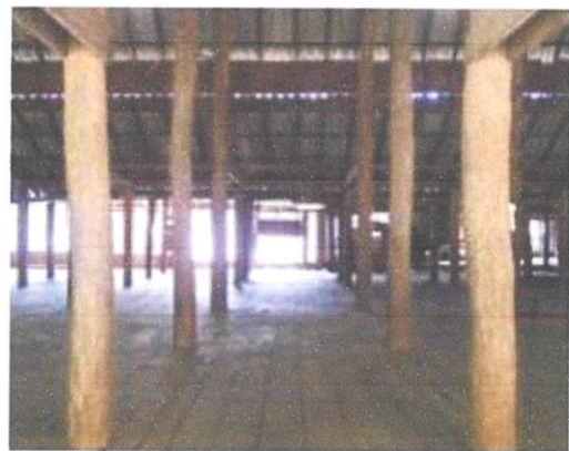
เสาไม้หน้าตัดกลม
