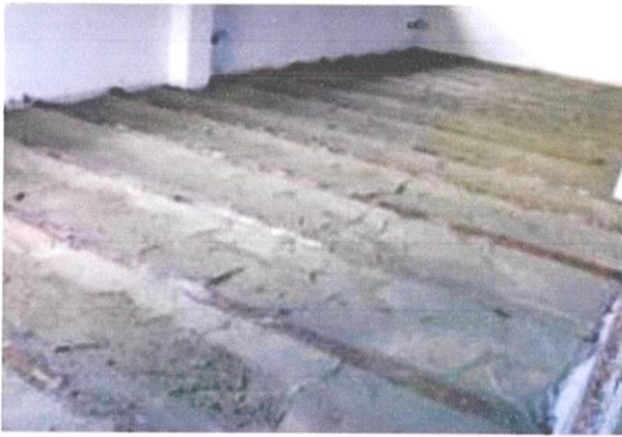
การวางตงบนพื้นคอนกรีต
