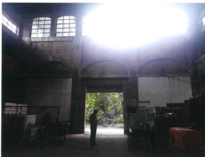
ภาพที่ 1.10 แสดงรูปด้านภายในทางเข้าอาคาร
