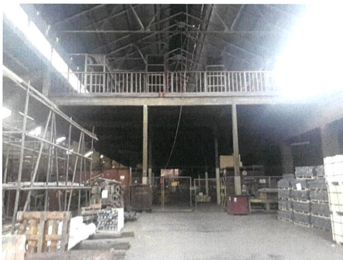
ภาพที่ 1.9 แสดงรูปด้านภายในอาคาร
