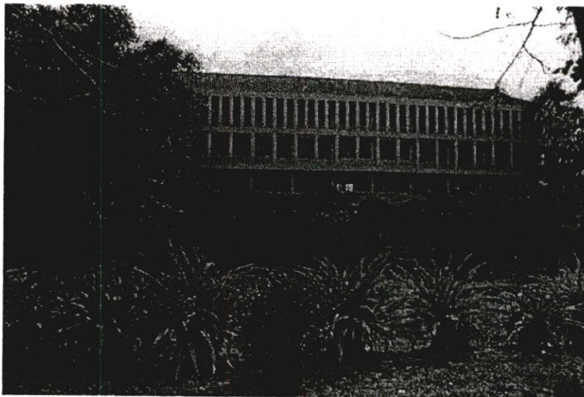
ภาพที่ 4.23 ลักษณะรูปทรงอาคารที่เป็นประเภทอาคารเรียน มีความสูงตั้งแต่ 3-4 ชั้น ปลูกสร้างอยู่ลึกเข้าไปจากถนนทางเข้า บริเวณด้านหน้าอาคารมีลักษณะที่โล่งกว้าง และประกอบไปด้วยบ่อน้ำที่ยังไม่มีการพัฒนา ขาดการจัดการระบบระบายน้ำ ดังนั้นน้ำในบ่อจึงมักจะเห่าน้ำเสีย (จากการสำรวจ ; 2545)
