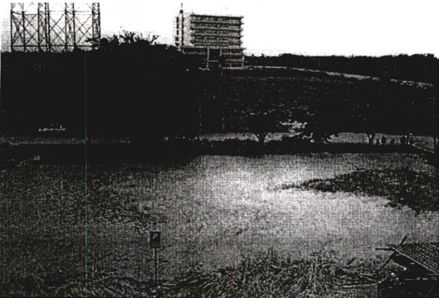
ภาพที่ 4.44 ลักษณะบ่อน้ำ ด้านหน้าของพื้นที่บริเวณที่พักอาศัย ของอาจารย์และเจ้าหน้าที่ เป็นบ่อที่ขุดขึ้นมาเพื่อใช้ในการรับน้ำทิ้ง ซึ่งปัจจุบันเกิดปัญหาเนื่องไม่มีการบำบัด จึงมักส่งกลิ่นเหม็นเน่า และบริเวณโดยรอบก็ไม่มีการพัฒนาตกแต่งจัดภูมิทัศน์แต่ อย่างไร (จากการสำรวจ ; 2545)
