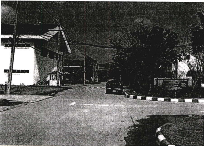
ภาพที่ 4.38 ลักษณะของสายไฟฟ้าที่ไม่เรียบร้อยในการพาดสาย จึงมักเกิดปัญหาในเรื่องของ ไฟฟ้าลัดวงจรเมื่อเกิดลมแรงและฝนตก (จากการสำรวจ ; 2545)
