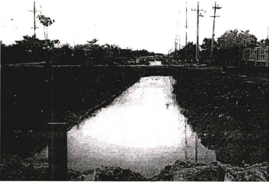
ภาพที่ 4.57 ขณะกำลังขุดเจาะดินเพื่อวางแนวท่อประปา และแนวท่อระบายน้ำบริเวณด้านถนน พุทธมณฑล สาย 5 (จากการสำรวจ ; 2545)
