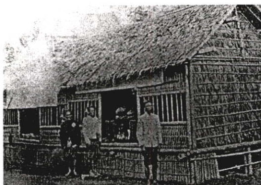
ภาพที่ ค.51 เรือนเครื่องผูกทางภาคกลางเน้นการก่อสร้างแบบใช้ผูกมัดด้วยหวายและเถาวัลย์
