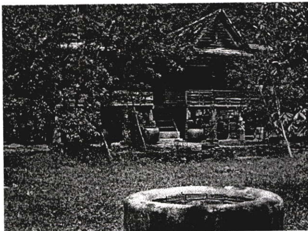
ภาพที่ ค.97 เรือนไทยมุสลิมส่วนมากจะมีบันไดทั้งด้านหน้าและด้านหลังของเรือน ทางขึ้นบันไดจะมีที่ล้างเท้า อาจจะก่ออิฐขึ้น ๆ เป็นบ่อพักน้ำ หรือใช้โถงขนาดเล็กใส่น้ำ เพื่อล้างเท้าก่อนขึ้นเรือน
