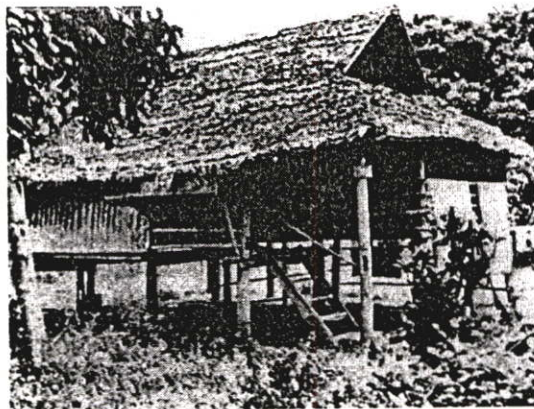
ภาพที่ ค.52 เรือนเครื่องผูกทางภาคอีสานมีการปลูกเป็นห้องมีระเบียบ ชาน คร้วไฟ
