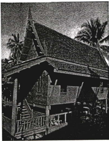
ภาพที่ ค.72 แสดงกันสาดเป็นองค์ประกอบที่ป้องกันแดด ป้องกันฝนและป้องกันความร้อน
