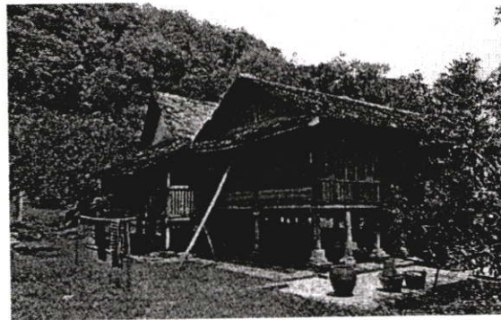
ภาพที่ ค.95 ส่วนหลังของเรือน จะลดระดับของพื้นเรือนลงและเป็นชานพักของบันไดลงด้านหลังของเรือน เพื่อใช้ไปอาบน้ำ
