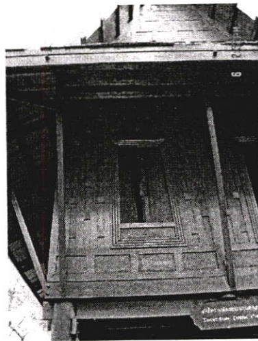
ภาพที่ ค.72 แสดงกันสาดเป็นองค์ประกอบที่ป้องกันแดด ป้องกันฝนและป้องกันความร้อน
