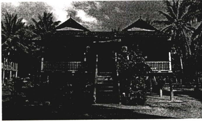
ภาพที่ ค.99 เฉลียงเป็นส่วนที่อยู่ด้านหน้าสุดของเรือน ซึ่งอยู่ภายใต้หลังคาของเรือน เป็นที่สำหรับใช้พักผ่อนและพื้นที่อเนกประสงค์
