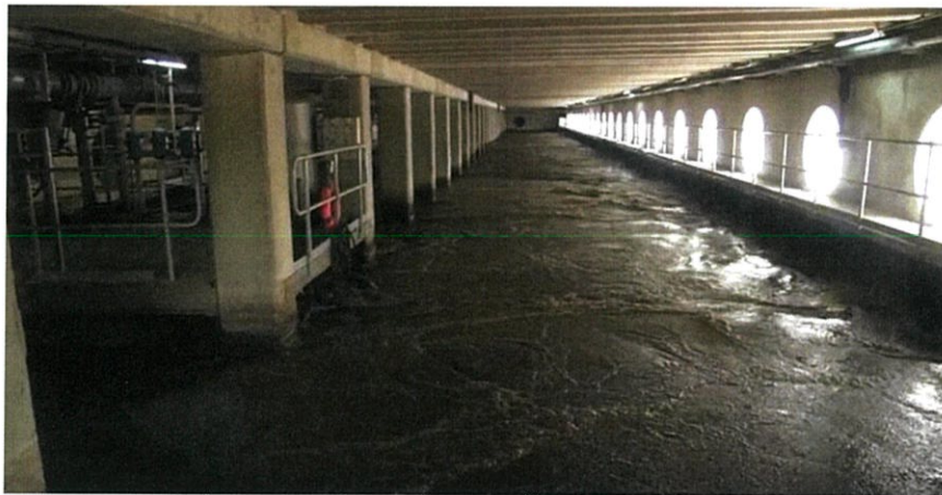
รูปที่ 3.7 ช่องที่ทำการลำเลียงน้ำเพื่อไปบ่อเติมอากาศ
