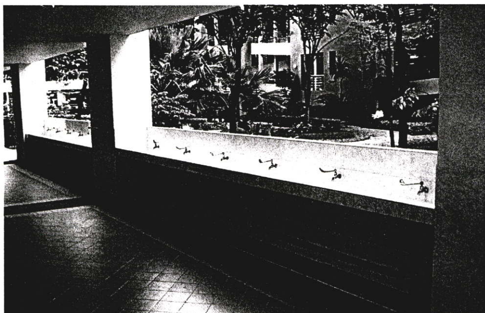
อ่างล้างมือบริเวณโรงอาหารมีความสูงจากพื้น 80 เซนติเมตรซึ่งเป็นระยะและมีรูปแบบที่เหมาะสมการใช้งานสำหรับเด็กพิเศษ
