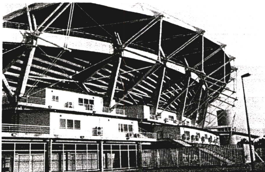
ภาพที่ 2.37 งานโครงสร้างโครงหลังคาและการทำงานของโครงสร้างทางวิศวกรรม
