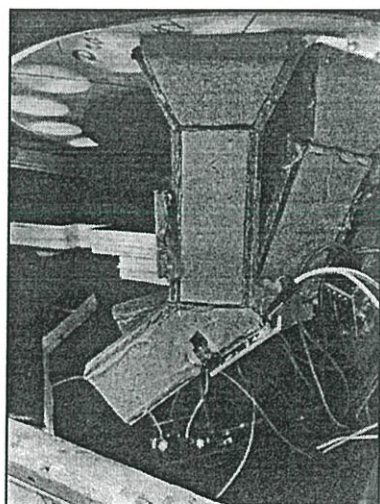
รูปที่ 4.5 รางเหรียญที่มีการชะลอความเร็ว และเวลาที่ใช้ในการนับ เหรียญบาทจำนวน 40 เหรียญ
