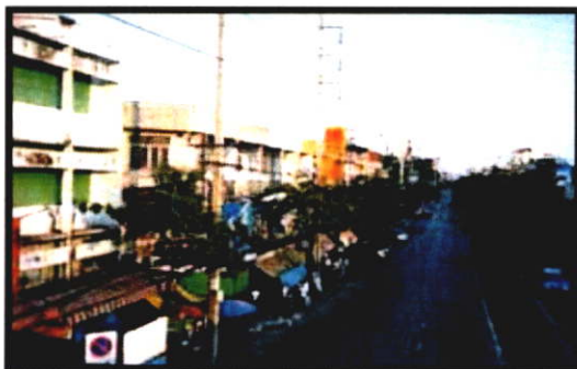
สภาพปัจจุบันของอาคารตึกแถว
