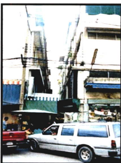
การต่อเติมพื้นที่ว่างด้านหลังอาคาร
