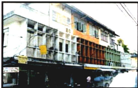
การต่อเติมเพิ่มจำนวนชั้นของอาคาร
