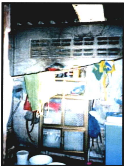
การวางของภายในพื้นที่ด้านหลังที่มีการต่อเติม
