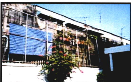
ลักษณะการต่อเติมพื้นที่ว่างด้านหลังอาคาร
