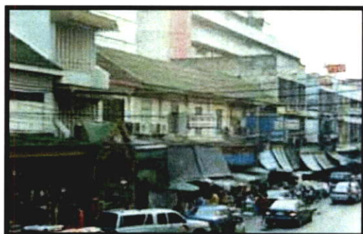
การจอดรถบริเวณด้านหน้าอาคารตึกแถว
