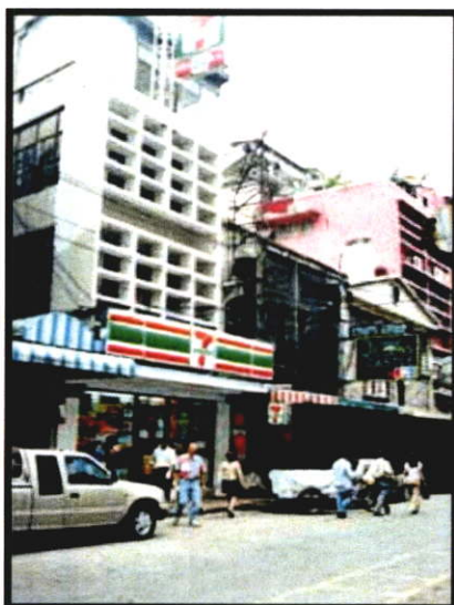
ลักษณะสภาพการต่อเติมอาคาร
