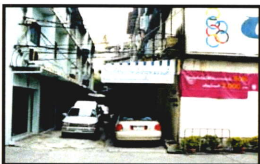
การจอดรถบริเวณด้านหลังอาคาร
