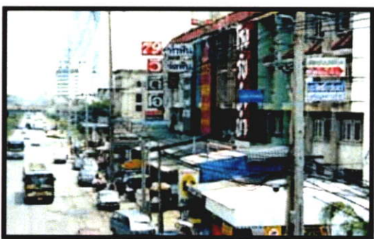
การต่อเติมพื้นที่ว่างด้านหน้าอาคาร
