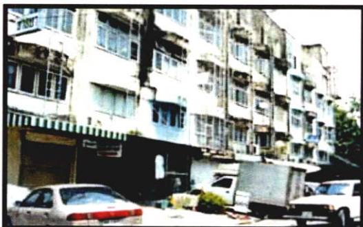
การจอดรถ และบันไดหนีไฟด้านหลังของอาคารตึกแถว
