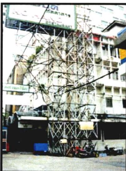
สภาพปัจจุบันของอาคาร
