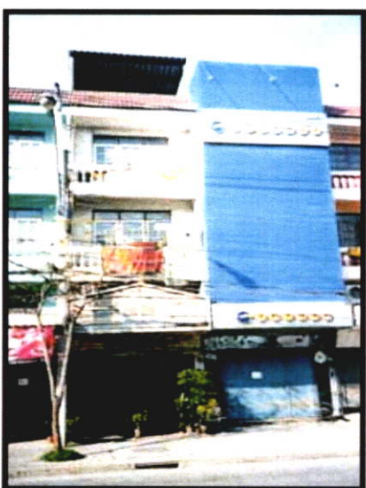
การต่อเติมหลังคาบริเวณชั้นดาดฟ้า
