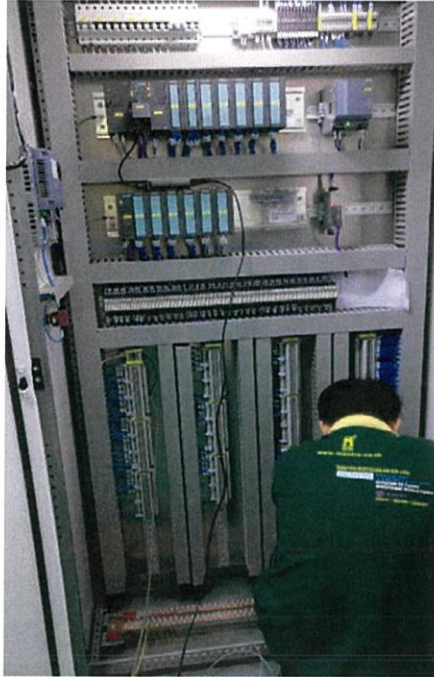
ภาพที่ 4.4 การเช็ค CARD PLC DI/DO และ AI/AO
