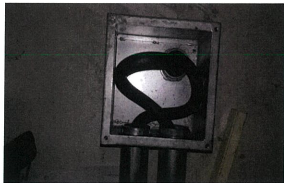
ภาพที่ 4.4 ลักษณะการเดินสายของหน้างานจริงซึ่งไม่ตรงกับลักษณะที่ระบุไว้จากการคำนวณ
