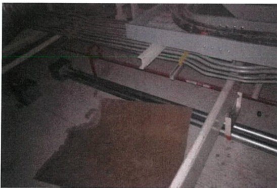
ภาพที่ 4.4 ลักษณะการเดินสายของหน้างานจริงซึ่งไม่ตรงกับลักษณะที่ระบุไว้จากการคำนวณ
