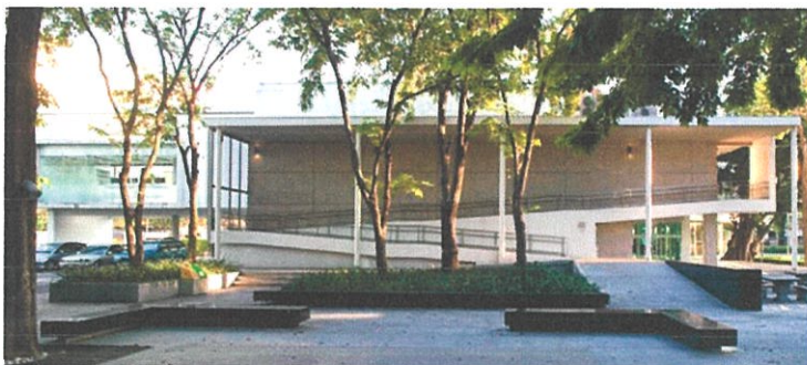
ภาพที่ 9.4 ด้านหลังอาคารโดยรวม
