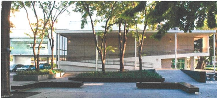
ภาพที่ 3.4 ด้านหลังอาคารโดยรวม
