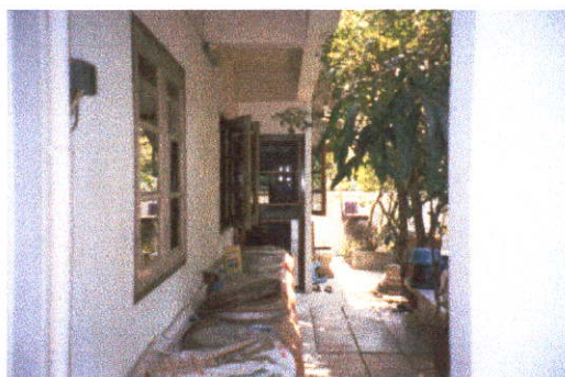
ส่วนครัว และซักล้างด้านข้างที่ต่อเติมเพิ่ม
