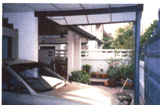
ส่วนเฉลียงด้านหน้าที่ต่อเติมรางระบายน้ำ และปูบล็อกเพิ่ม
