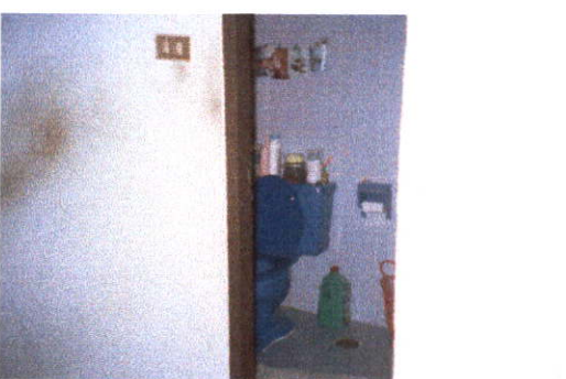
ส่วนห้องน้ำ - ส้วม ชั้นบนที่ยังไม่ได้ทำการต่อเติม
