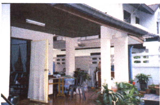
ส่วนเฉลียงด้านข้างที่ต่อเติมเพิ่ม
