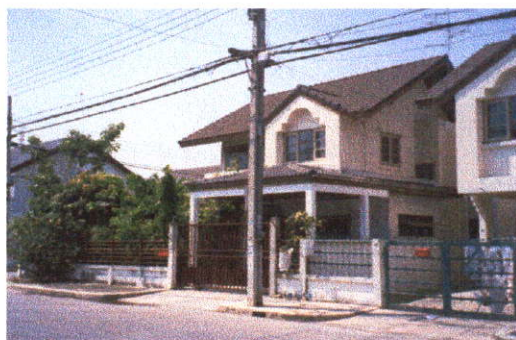
ส่วนโถงเอนกประสงค์ชั้นล่างที่ต่อเติมเพิ่ม
