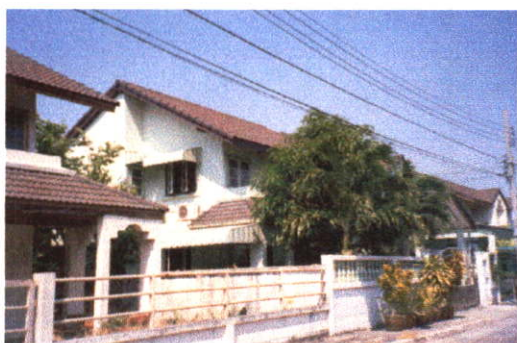
การต่อเติมกันสาดเพิ่มในส่วนด้านข้างบ้านพักอาศัย
