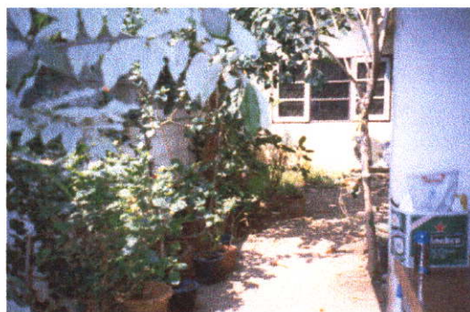
ส่วนห้องนอนชั้นล่างที่ต่อเติมเพิ่ม
