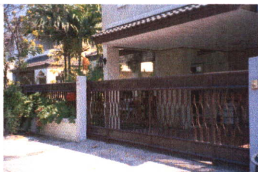
ส่วนจอดรถที่ต่อเติมเพิ่ม
