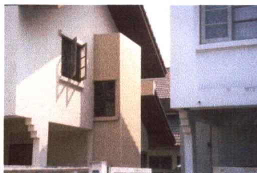
ส่วนด้านข้างบ้านพักอาศัย ที่ยังไม่ได้ทำการต่อเติม
