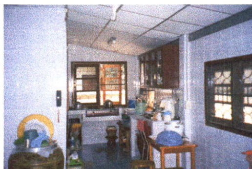
ส่วนครัวที่ต่อเติมเพิ่ม
