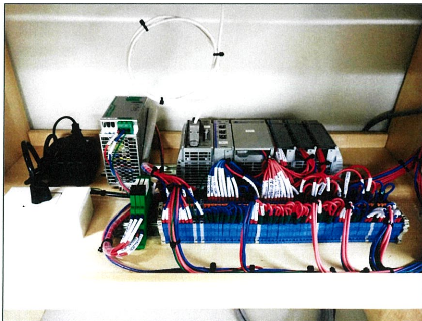
ภาพที่ 3.61 จัดวางอุปกรณ์และ Wiring สายไฟ
