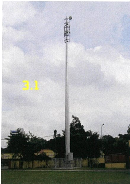
รูปที่ 2.9 เสาโทรคมนาคมแบบ Monopole
