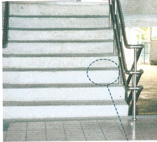
รูปที่ 4.31 รูปแสดงลูกตั้งและลูกนอนของบันไดหนีไฟอาคารเอ็มโพเรียมทาวเวอร์
