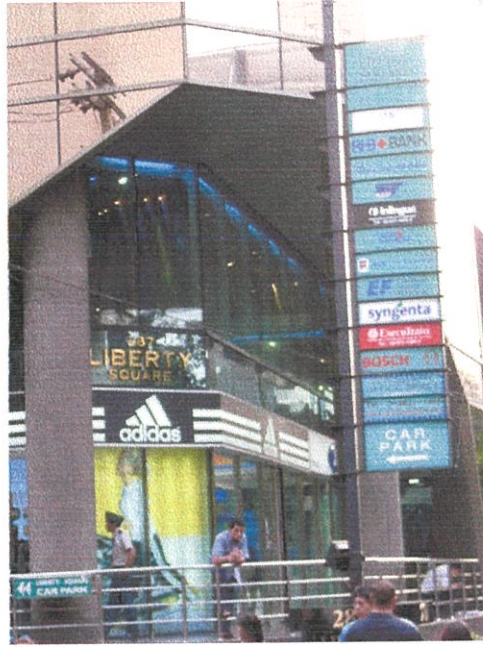
รูปที่ 4.23 แสดงทัศนียภาพทางด้านหน้าอาคารลิเบอร์ตี้สแควร์
