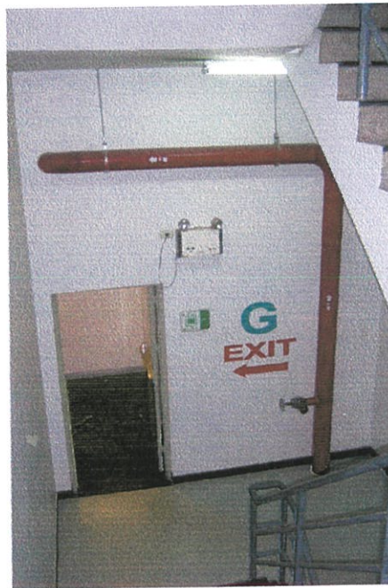
รูปที่ 4.26 แสดงบันไดหนีไฟอาคารดิเบอร์ตีสแควร์
