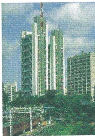
รูปที่ 2.26 การออกแบบอาคารและเลือกใช้วัสดุก่อสร้างที่ทนไฟ
