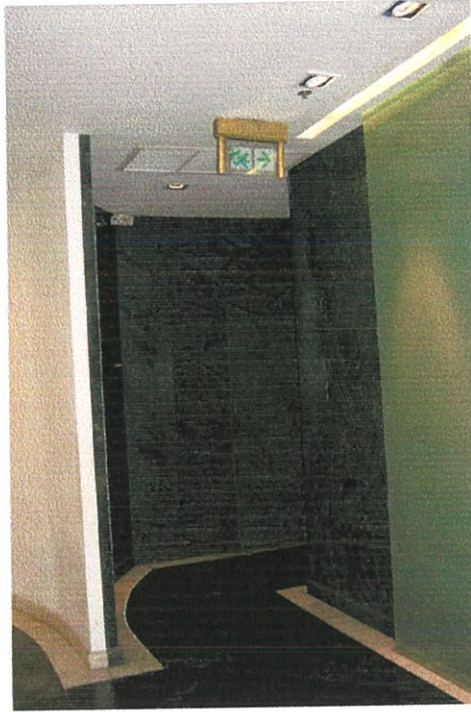
รูปที่ 4.25 แสดงทางออกบันไดหนีไฟอาคารดิเบอร์ตีสแควร์
