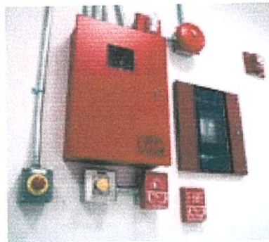
รูปที่ 2.46 อุปกรณ์ตรวจจับและเริ่มสัญญาณ
