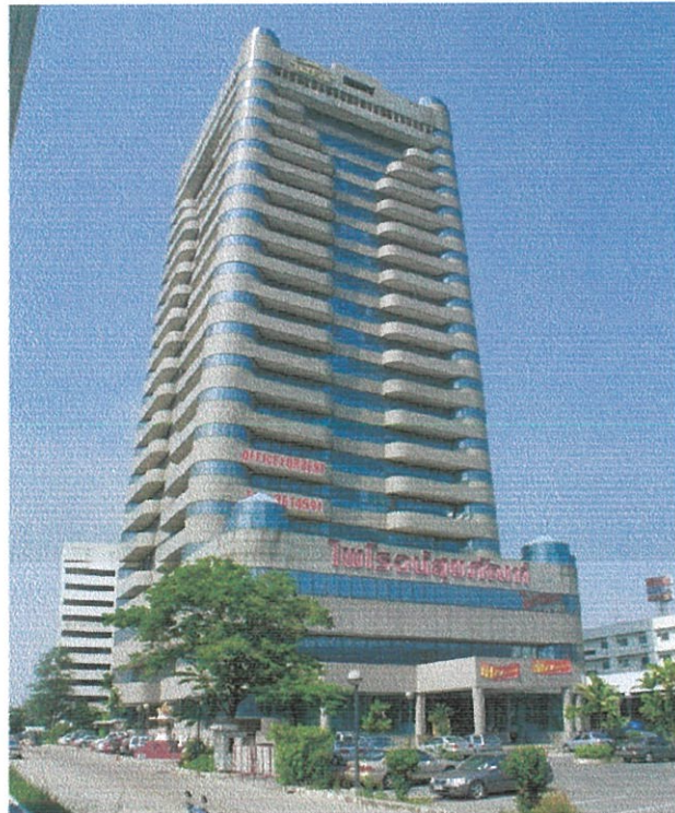
รูปที่ 4.4 แสดงทัศนียภาพโดยรอบอาคารไฟโรจน์กิจจา
