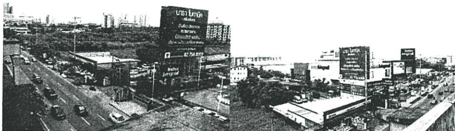
ภาพที่ 5.23 การเดินทางมายังโครงการและ ถนนหน้าโครงการจากมุมมอง
