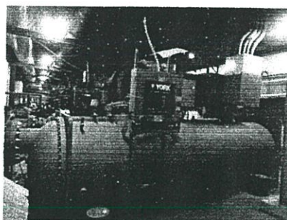
ภาพที่ 7.2 แสดง Chiller Water Cool ของอาคารภูมิสิริมังคลานุสรณ์ โรงพยาบาลจุฬาลงกรณ์
