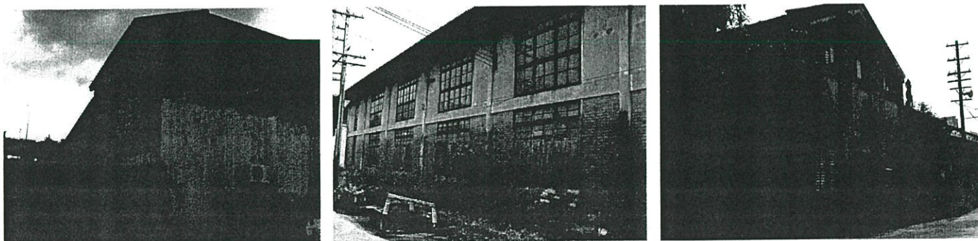
รูปที่ 5 แสดงรูปถ่ายภายนอกอาคาร
