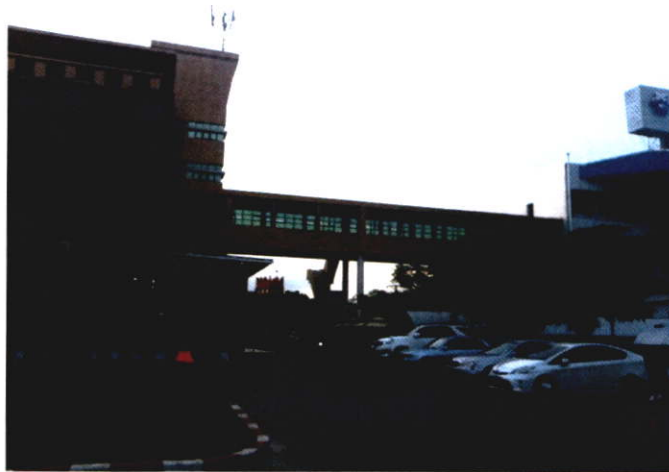
รูปที่ 3.18 แสดงภาพถ่ายทางเชื่อมสองอาคาร
