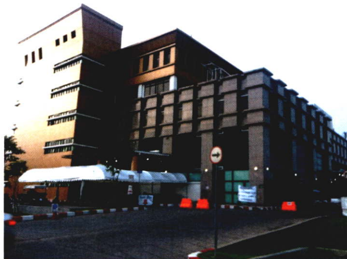
รูปที่ 3.17 แสดงภาพถ่ายอาคารที่เป็นส่วนต่อขยาย
