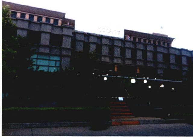
รูปที่ 3.20 แสดงภาพถ่ายด้านหลังอาคาร
