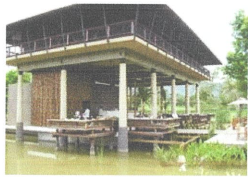
รูปที่ 1.53 อาคารภายนอกด้านข้าง
