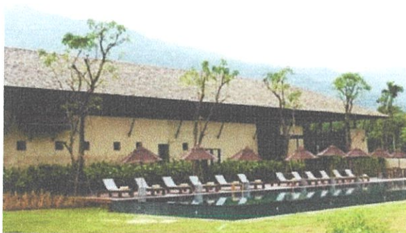
รูปที่1.60 รูปภายนอกอาคารด้านข้าง
