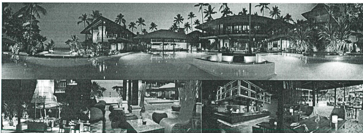
รูปที่ 2.9 ภาพงานออกแบบตัวอาคารภายนอก และ การตกแต่งภายในอาคาร
