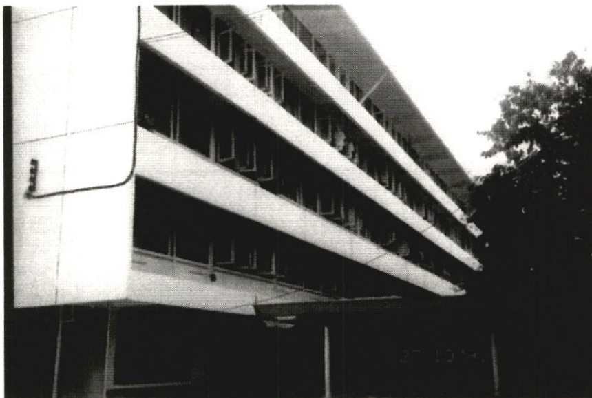
ภาพที่ 3.31 แสดงอุปกรณ์บังแดดด้านหน้าอาคาร (ทิศเหนือ)
