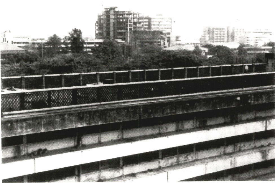
ภาพที่ 3.29 แสดงหลังคาคอนกรีตเสริมเหล็ก หนา 0.20 ม.
