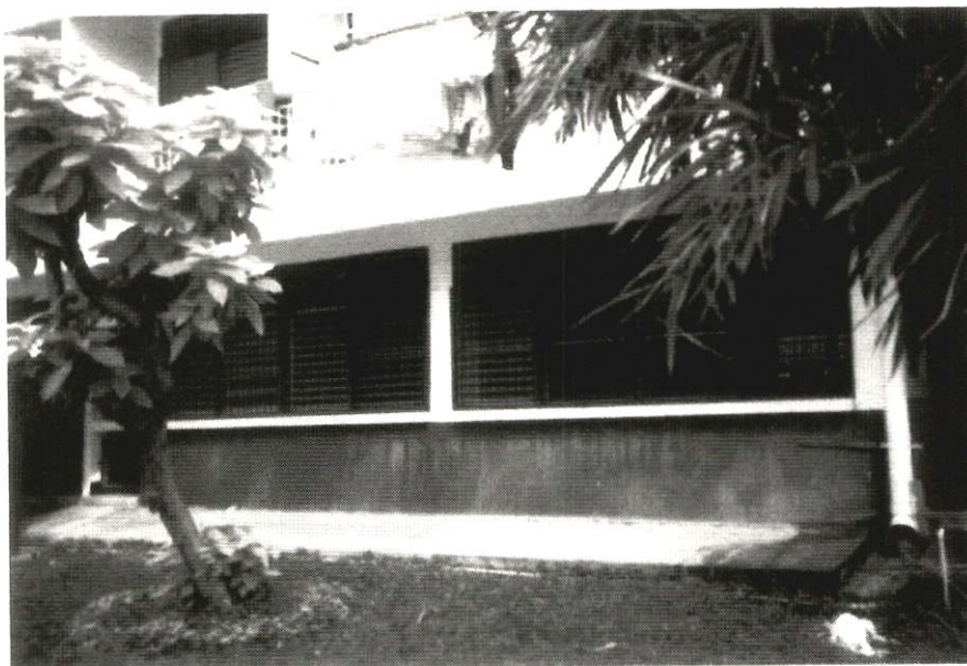
ภาพที่ 3.26 แสดงหน้าต่างบานเกล็ดปรับองศา กระจกใส หนา 5 มม. พร้อมช่องระบายอากาศ
