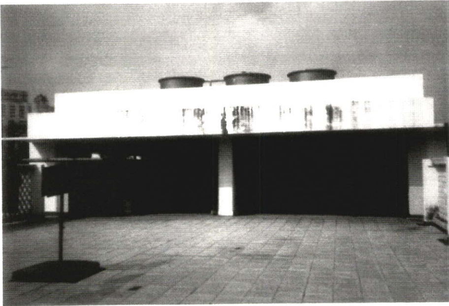
ภาพที่ 3.30 แสดงหลังคาคอนกรีตเสริมเหล็ก หนา 0.22 ม.
