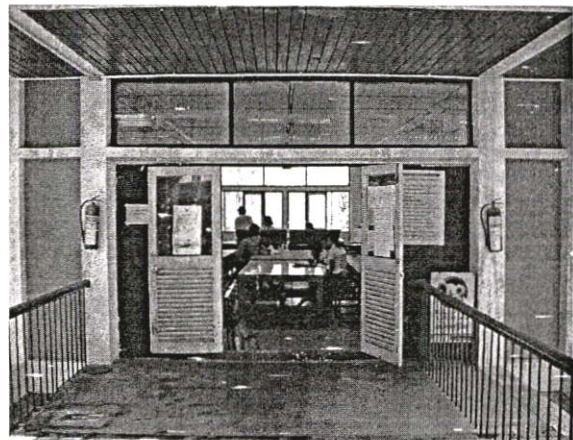
ทางเข้าด้านหน้าเป็นประตูเปิดบานคู่
