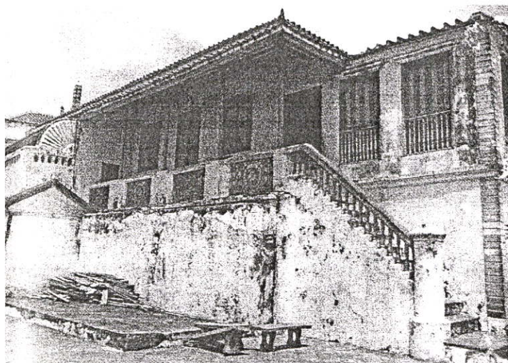
รูปที่ 2.11 การบูรณะอาคารเดิมที่ชำรุดทรุดโทรมมาก
