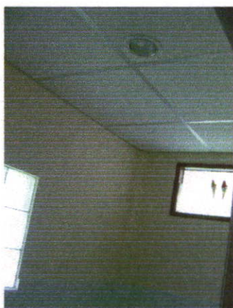
ภาพที่ 3.73 ฝ้าเพดานในห้องพักใช้โครงT-BAR
