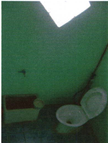
ภาพที่ 3.28 สุขภัณฑ์แบบนั่งราบ / ใช้น้ำราด
