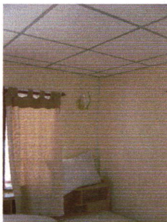
ภาพที่ 3.71 ฝ้าเพดานในห้องพักใช้ T-BAR
