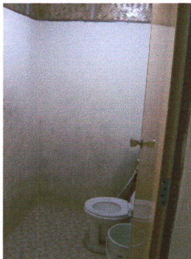
ภาพที่ 3.53 ภายในห้องน้ำ ไม้แยกส่วนเปียก-แห้ง กรุแผ่นไม้ไผ่สานตกแต่งผนังช่วงบน
